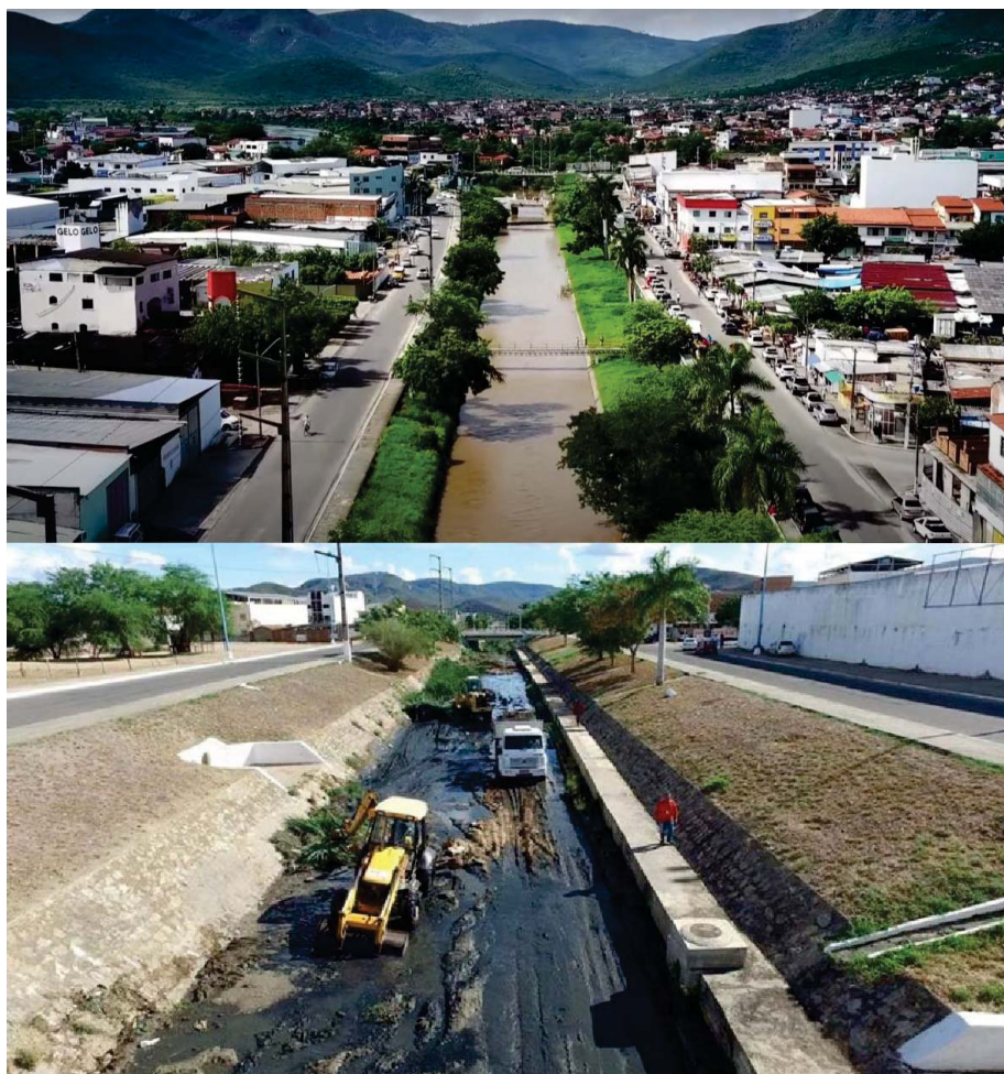
Figura 16. Canal do Rio Jequezinho (futura área do estacionamento na margem direita) no período chuvoso (acima) em dezembro/2021 (Fonte: PS Drone) e com obras de limpeza no período seco (abaixo). Fonte: Drone Solução Filmes.
