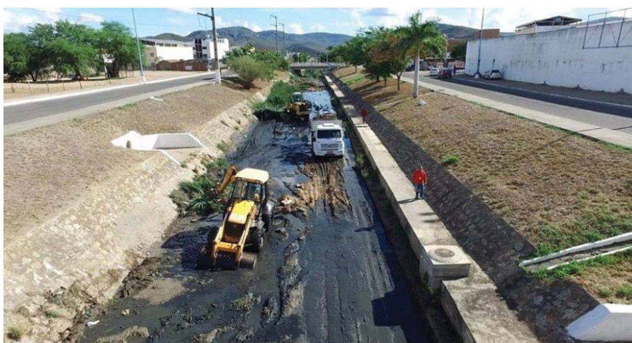
Figura 11. Canal do Rio Jequezinho no local do empreendimento no período seco. Fonte: Drone Solução Filmes.
