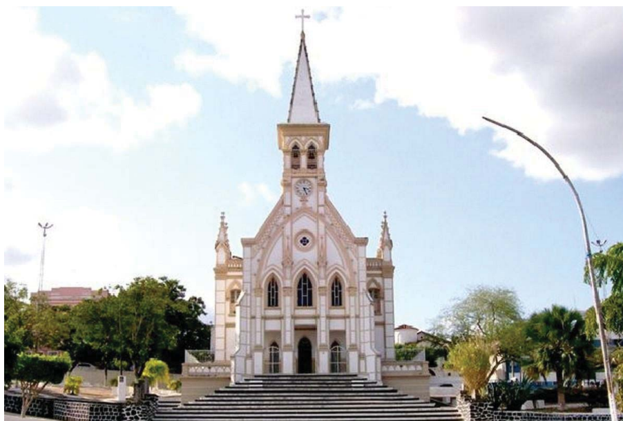
Figura 38. Catedral de Santo Antônio, próximo ao empreendimento. Fonte: https://www.guiadoturismobrasil.com/cidade/BA/276/jequie .
