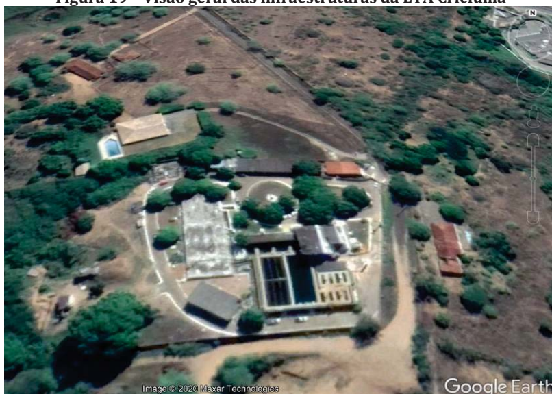
Figura 19 - Visão geral das infraestruturas da ETA Criciúma
