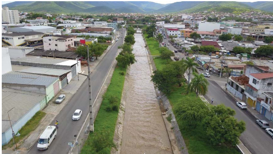
Figura 2. Área de construção do estacionamento (margem direita). Fonte: Prefeitura Municipal de Jequié (2021).
