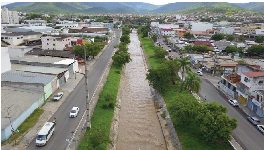
Figura 3. Área de construção do estacionamento (margem direita). Fonte: Prefeitura Municipal de Jequié (2021).
