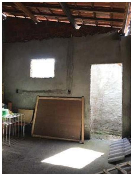
*Imóvel receberá reforma completa com implantação de revestimento nas paredes, troca da rede elétrica, implantação de novas esquadrias etc ....*
