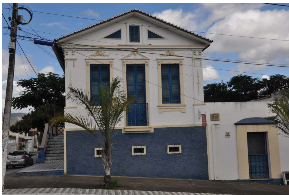
As imagens contidas nesta página do processo foram registradas em 19 de julho de 2018, após a execução de obras de reforma do casarão, ocorrida em 2013.
