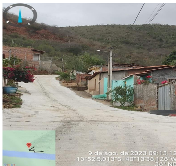
Depois – 2º Trav de acesso, “Barragem Da Pedra”
