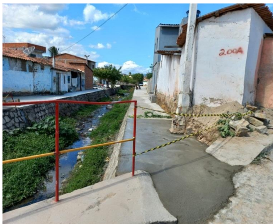
Manutenção de Diversas Estruturas em Concreto Usinado.
