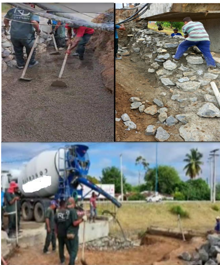
Manutenção de Pontes, Estruturas em Concreto Usinado.
