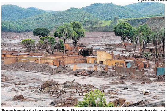
Rompimento da barragem de Fundão matou 19 pessoas em 5 de novembro de 2015
