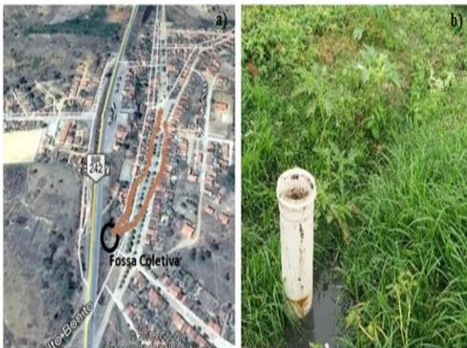
Figura 66- Fossa coletiva do Povoado Zuca- Boa Vista do Tupim/BA: a) Visão aérea da localização da fossa coletiva; b) Imagem da fossa entupida.
