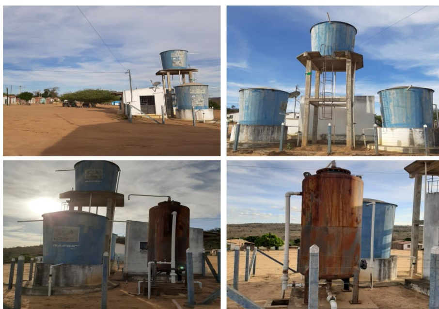
Figura 58- Dessalinizador do SSAA de Cambuí/Barra Verde
