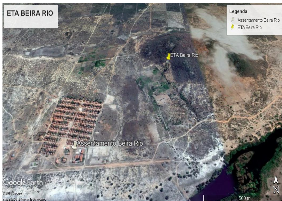
Figura 53- Localização da ETA Beira Rio
