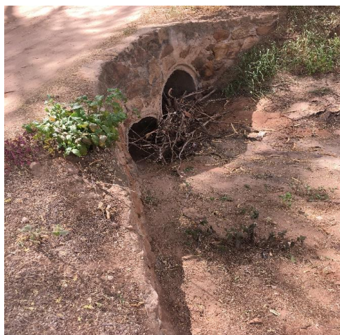
Figura 94- Bueiro de drenagem de águas pluviais na entrada no Assentamento Polinésia- Boa Vista do Tupim/BA
