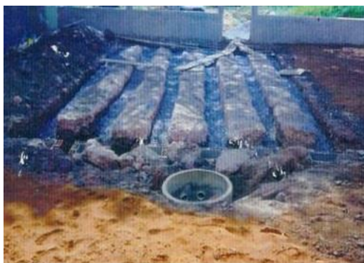
Figura 141 - Valas de infiltração construídas e esquema do leito filtrante
