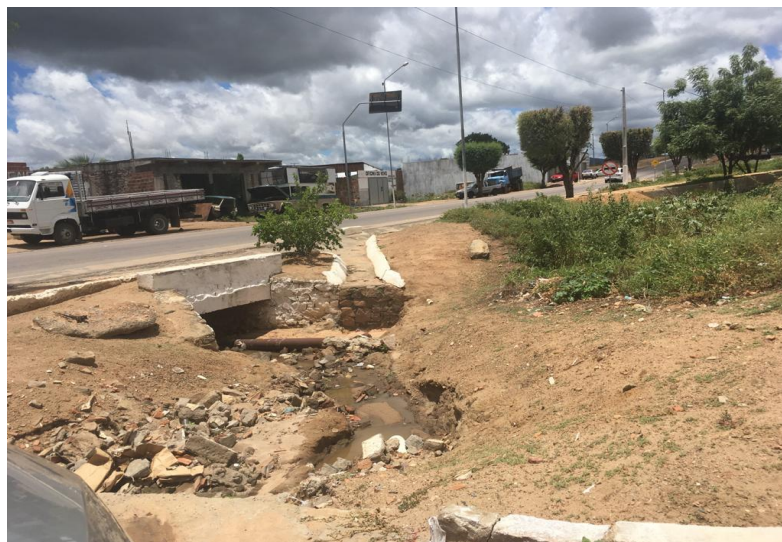
Figura 95 - Bueiro de travessia na BA-130 – Boa Vista do Tupim/BA
