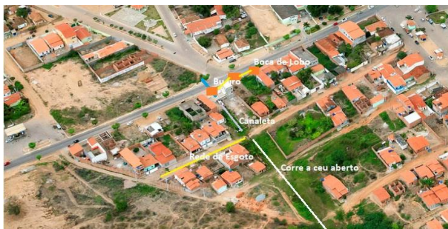
Figura 86-Rede de Drenagem na BA-130 – Boa Vista do Tupim/BA
