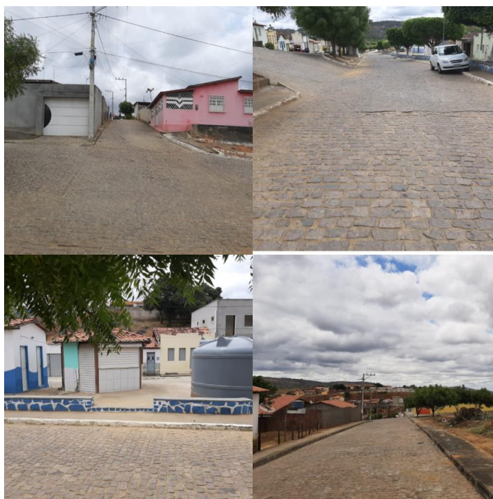
Figura 88- Ruas da Localidade de Zuca com pavimentação e ausência de dispositivos de drenagem- Boa Vista do Tupim/BA
