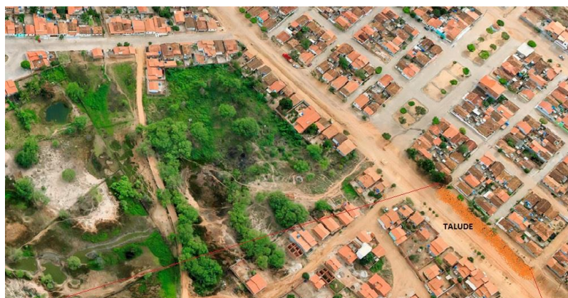
Figura 84- Risco de Instabilidade de Talude – Boa Vista do Tupim/BA
