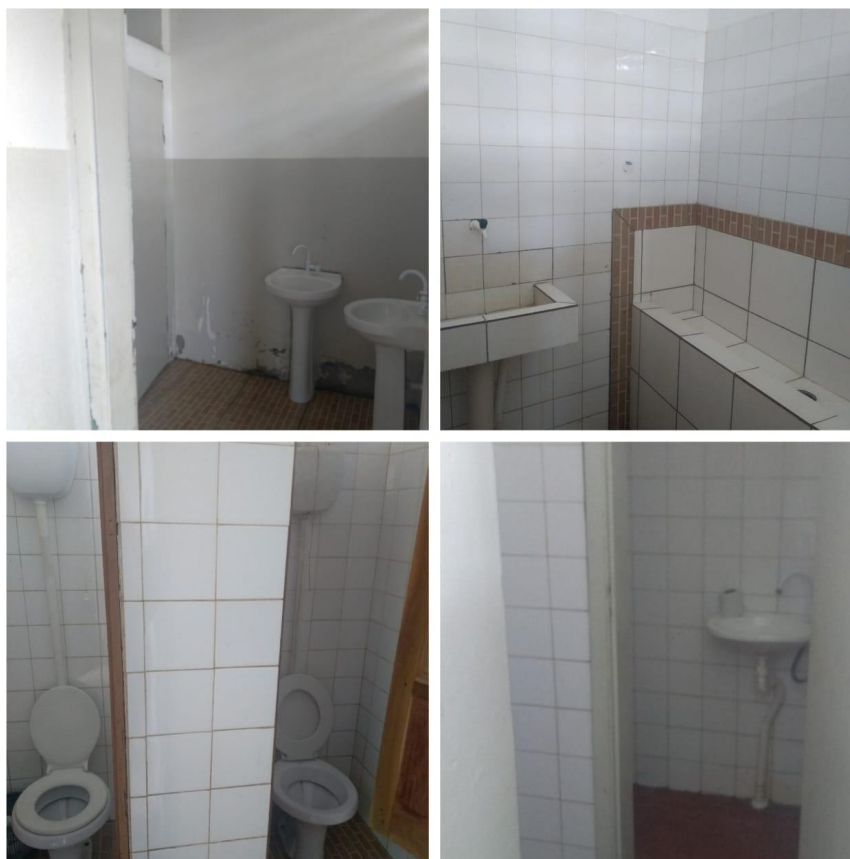
Figura 116- Sanitário Público da Feira da Sede de Boa Vista do Tupim
