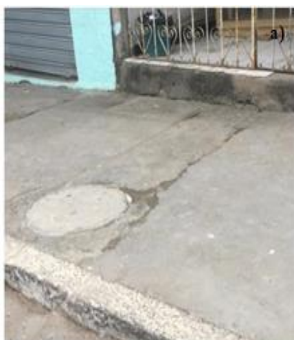
Figura 71 - Ligações prediais de esgoto, (a) existência de caixa de limpeza e (b) desenho esquemático da caixa – Boa Vista do Tupim/BA
