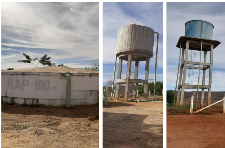
Figura 45- Estrutura de Reservação do SAA Santa Luzia
