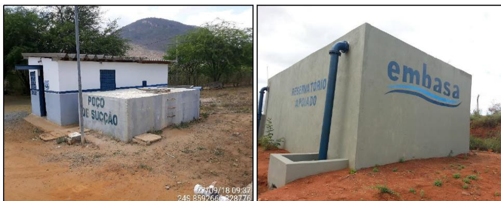
RAP de 20 m 3
