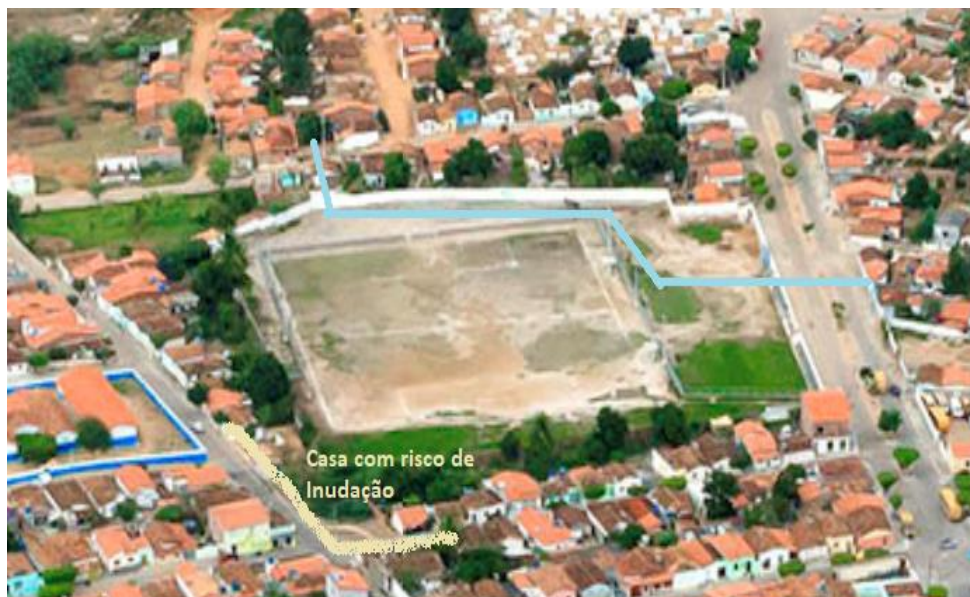
Figura 100 - Galeria de águas pluviais passando dentro do Estádio
