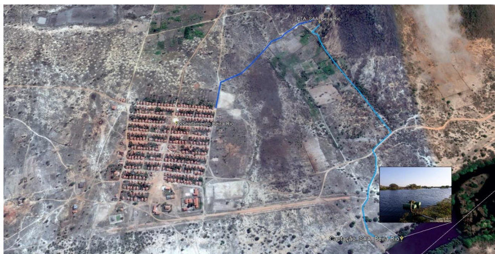
Figura 52- Local de Captação de água do SAA Beira Rio
