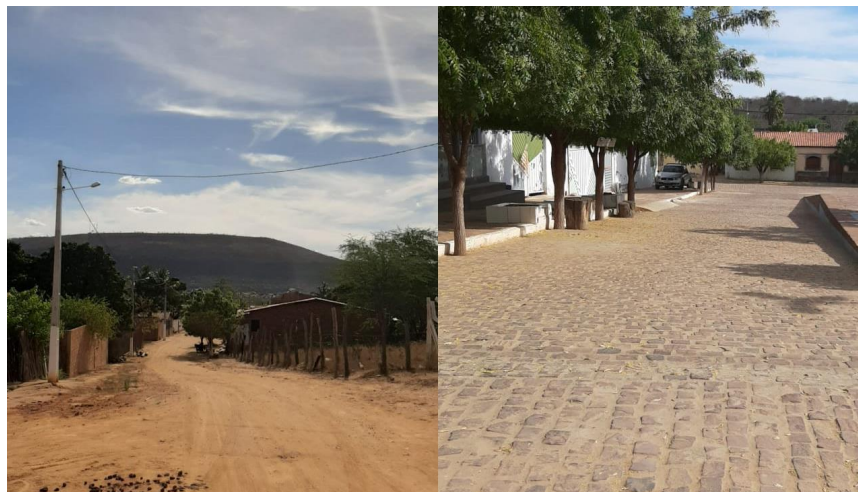
Figura 92- Trechos com e sem pavimentação de vias na localidade de Santa Luzia- Boa Vista do Tupim/BA
