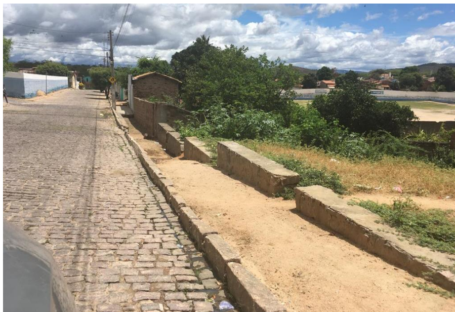
Figura 85 – Casa abaixo do nível da rua – Boa Vista do Tupim/BA
