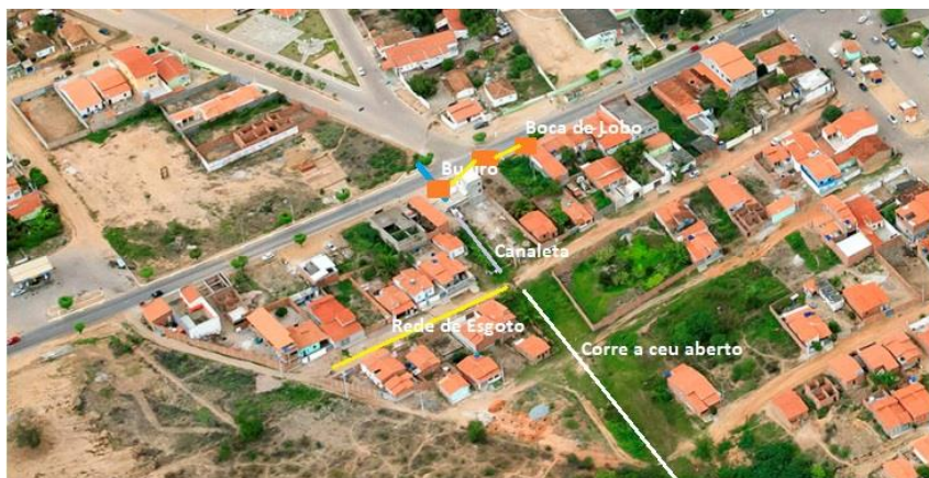
Figura 99 - Galeria de águas pluviais passando dentro de lote urbano
