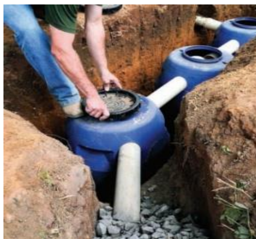
Figura 148 – Instalação das fossas sépticas econômicas
