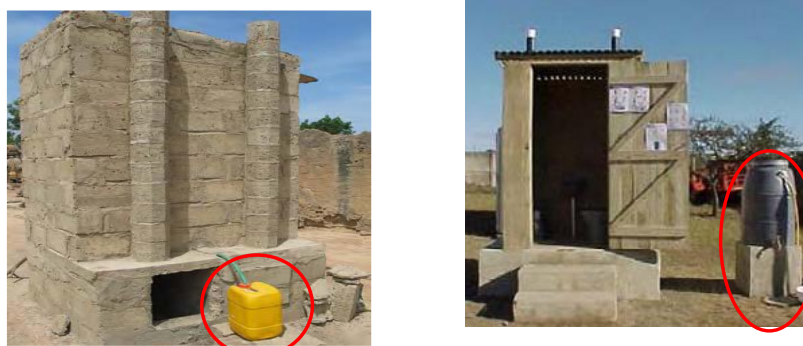
Figura 155 – Bombonas de armazenamento temporário (esquerda) e de estocagem (direita) em sanitário com separação de urina implantados em países da África.
