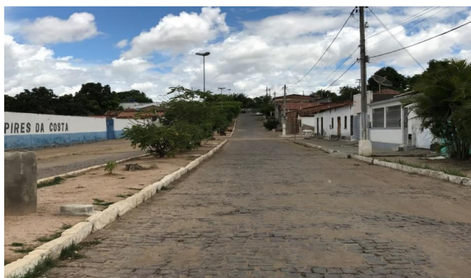
Figura 102 - Rua que sofre com alagamentos nos períodos de chuvas intensas-Boa Vista do Tupim/BA
