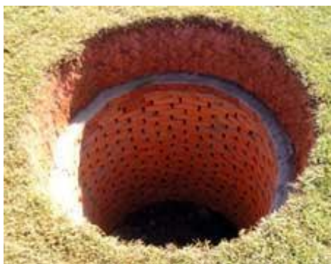
Figura 142 – Tipologia de sumidouro: sumidouro de tijolo
