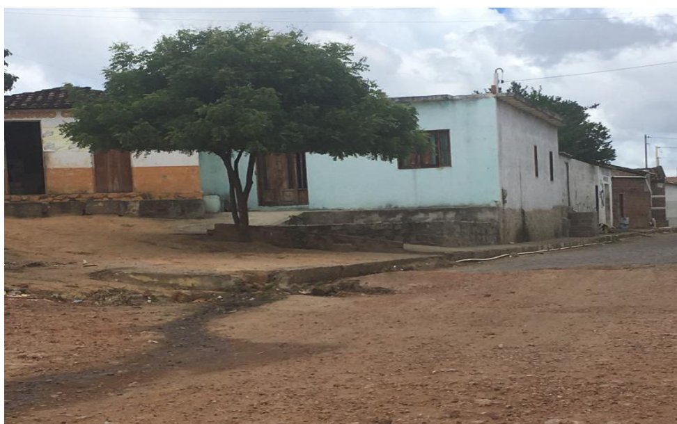
Figura 79- Lançamento de esgoto a céu aberto no final da Rua Laudelino dos Santos
