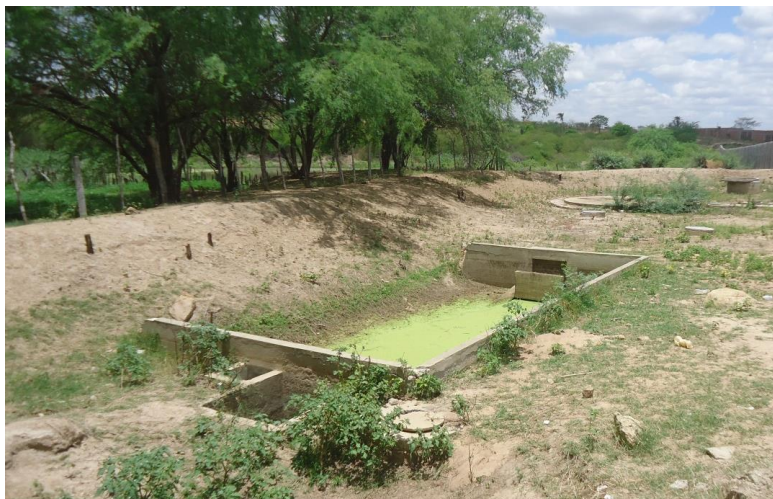
Figura 74- Unidades de tratamento preliminar de esgoto do SES de Boa Vista do Tupim
