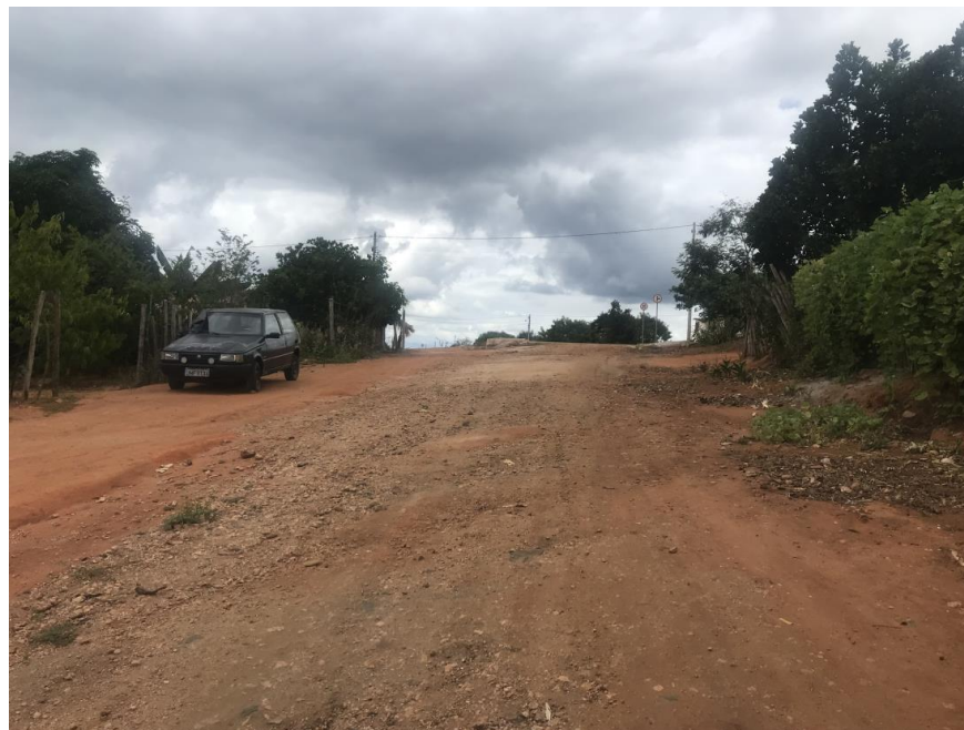
Figura 27: Fim do trecho 01 – (Coord. 302969/ 8589914)
