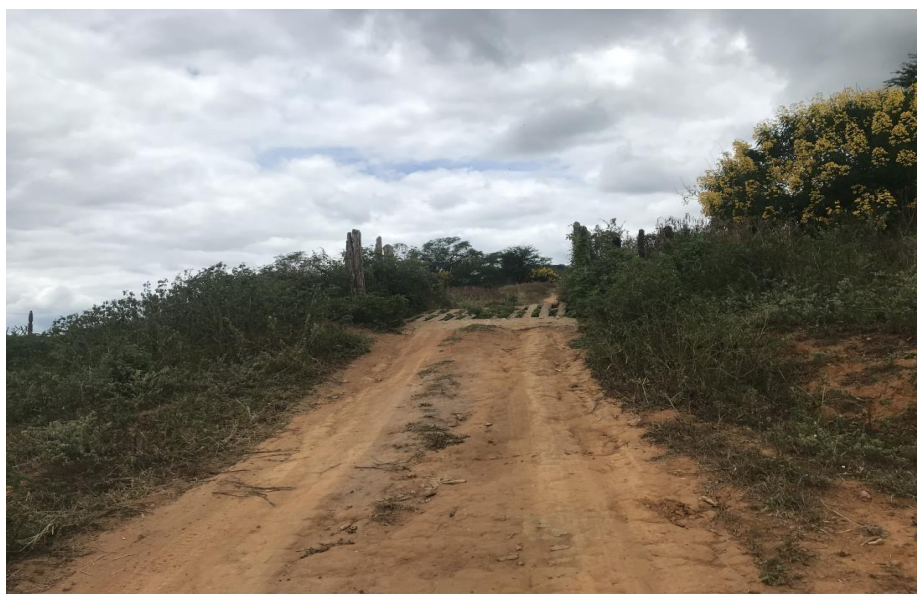
Figura 10: Trecho 01 – Mata burro a ser substituído - (Coord. 294098/8585796)
