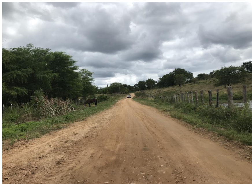
Figura 02: Trecho 01 – Ponto de implantação BTTC 100 (Coord. 293178/ 8580510)
