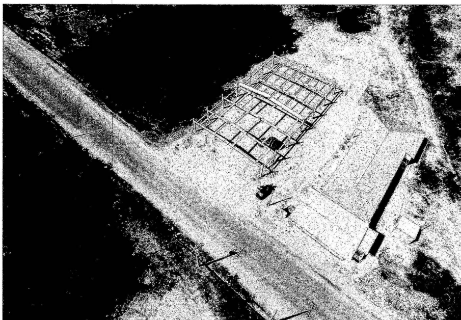
INSTALAÇÃO DAS VIGAS TRANSVERSAIS E TERÇAS DA ESTRUTURA PRÉ FABRICADAS
