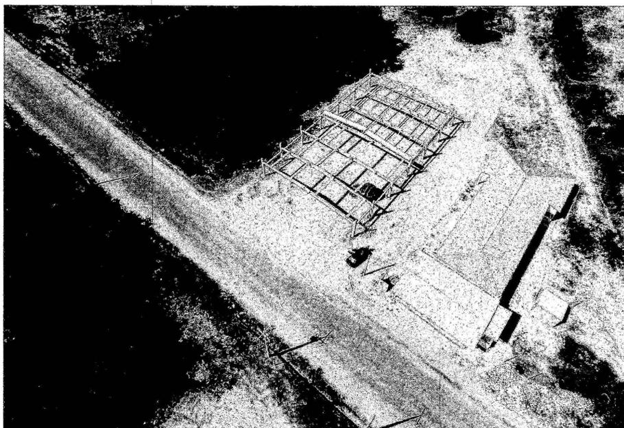
INSTALAÇÃO DAS VIGAS TRANSVERSAIS E TERÇAS DA ESTRUTURA PRÉ FABRICADAS
