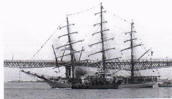
Os mastros do veleiro se chocaram contra uma ponte basculante para pedestres
