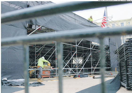
Trabalhadores constroem barreiras de 2,4 m próximo à Casa Branca e ao Capitólio
