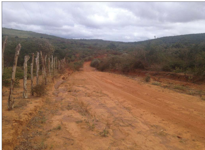
Vista de trecho a ser recuperado.
