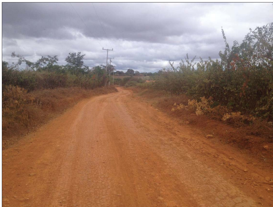
Vista de trecho a ser recuperado.
