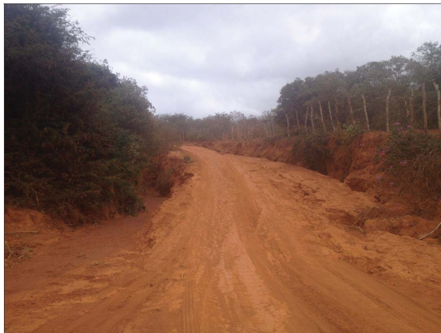
Vista de trecho a ser recuperado.
