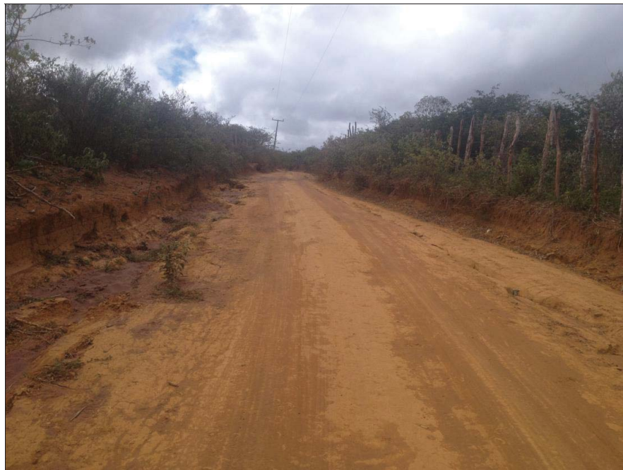
Vista de trecho a ser recuperado.
