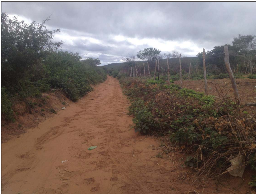
Vista de trecho a ser recuperado. Necessidade de remoção de cerca.
