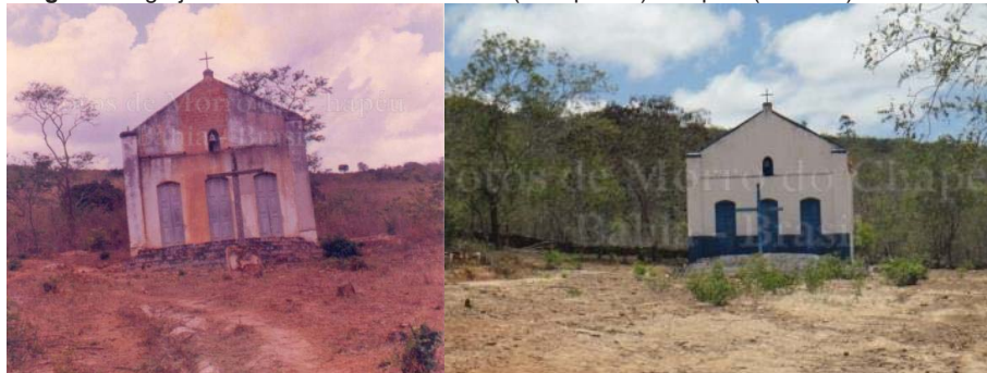
Figura 4 - Igrejinha em Vila do Ventura antes (à esquerda) e depois (à direita) da reforma.
