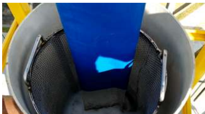
Figura 3: Caixa de Recepção e Distribuição
