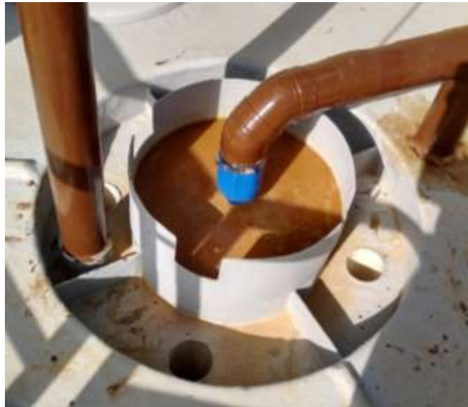
Figura 2: Caixa de Controle Operacional - CCO
