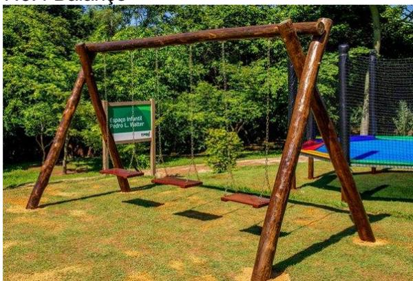
Construído em tronco de eucalipto do tipo citriodora com tratamento em autoclave. Composto por 03 balanços sustentados por 03 travessões na horizontal e 06 pilares. Os assentos deverão ser em madeira ou material emborrachado, não possuírem bordas, saliências ou rebarbas, garantindo segurança do uso de tal equipamento. Sistemas de correntes em elo de 5mm galvanizadas ou tirantes deverão receber capa plástica grossa de proteção, para evitar abrasão com o contato.
