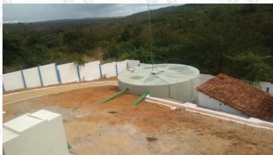
» Foto 05 – Reservatório de distribuição localizado na ETA
