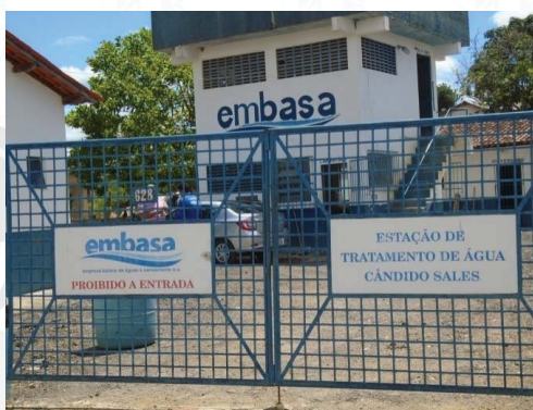
Foto 04 – Acesso à Estação de Tratamento de Água – ETA
