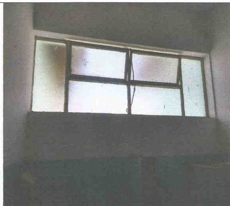
Figura 2.1: Janelas – Banheiro Externo, corredor.
