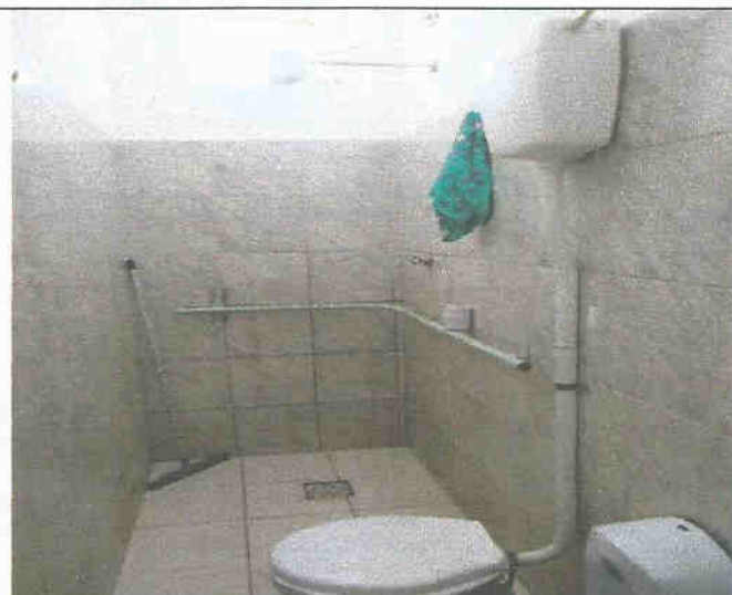
Figura 5.1: Banheiro Enfermaria Feminina A.
