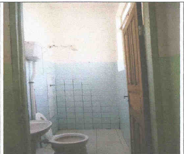
Figura 3.1: Banheiro Enfermaria Masculina D.
