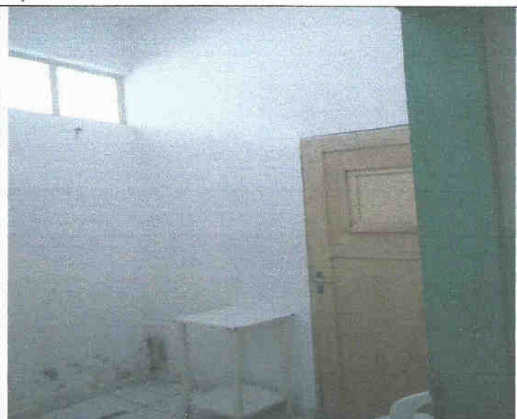
Figura 1.1: Interior da Sala
