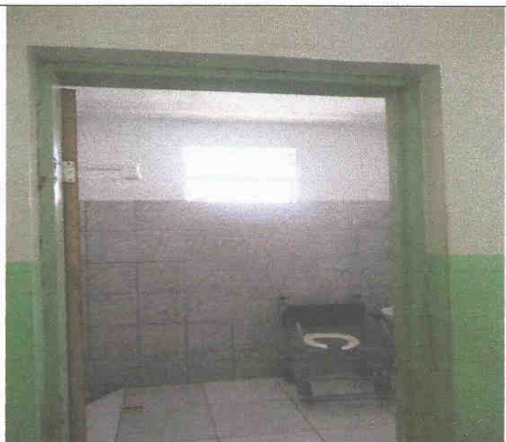
Figura 4.1: Banheiro Enfermaria Masculina C.
