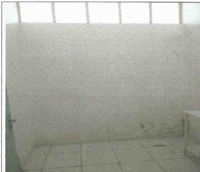
Figura 1: Interior da Sala
