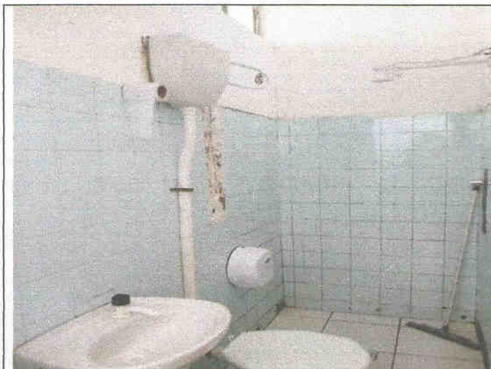
Figura 5: Banheiro Enfermaria Feminina B.
