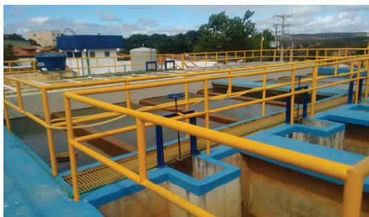
Foto 03 – Vista dos floculadores e decantadores
