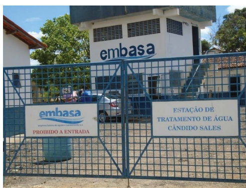
Foto 05 – Acesso à Estação de Tratamento de Água – ETA
