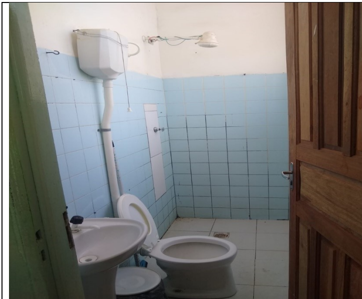
Figura 3: Banheiro Enfermaria Masculina D.
