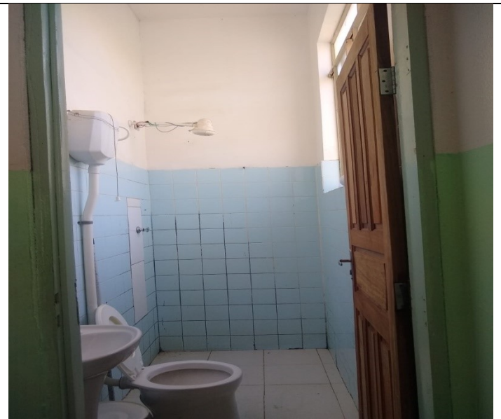
Figura 3.1: Banheiro Enfermaria Masculina D.
