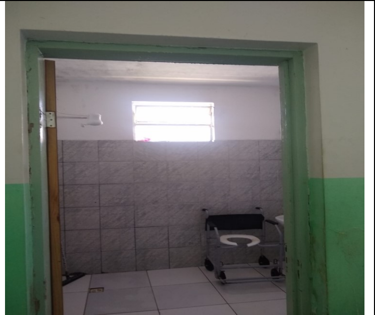
Figura 4.1: Banheiro Enfermaria Masculina C.
