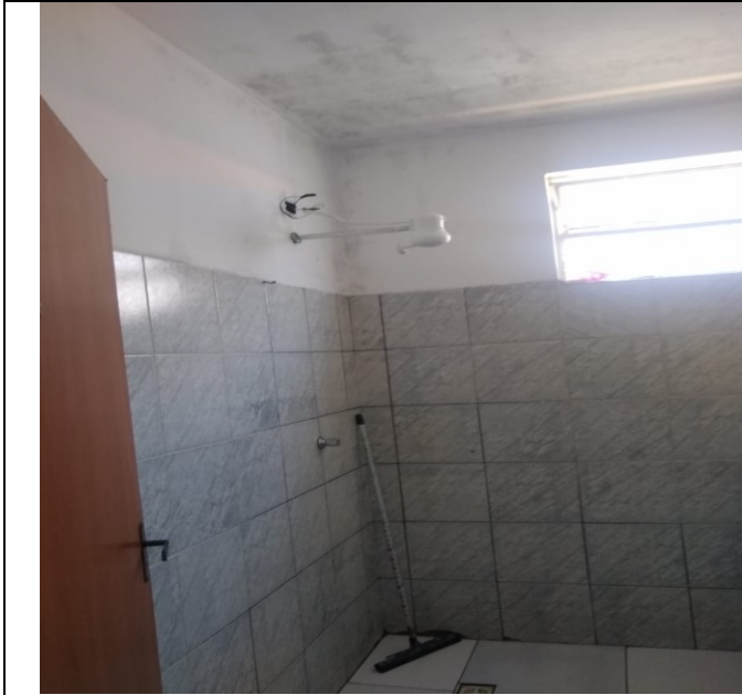
Figura 4: Banheiro Enfermaria Masculina C.
