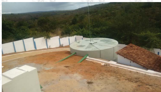
Foto 05 – Reservatório de distribuição localizado na ETA
