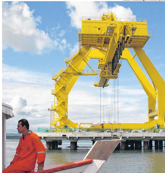
O projeto do estaleiro foi interrompido com 82% das obras civis concluídas
