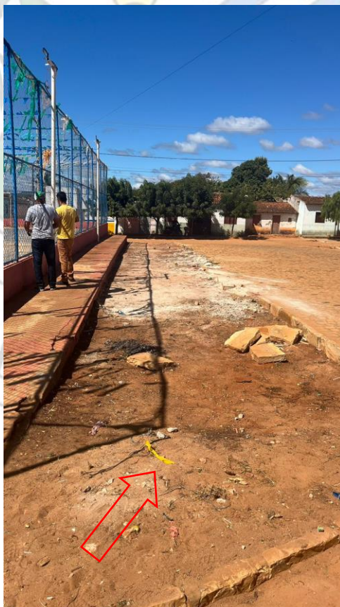
Área onde será construída arquibancada e pavimentada
