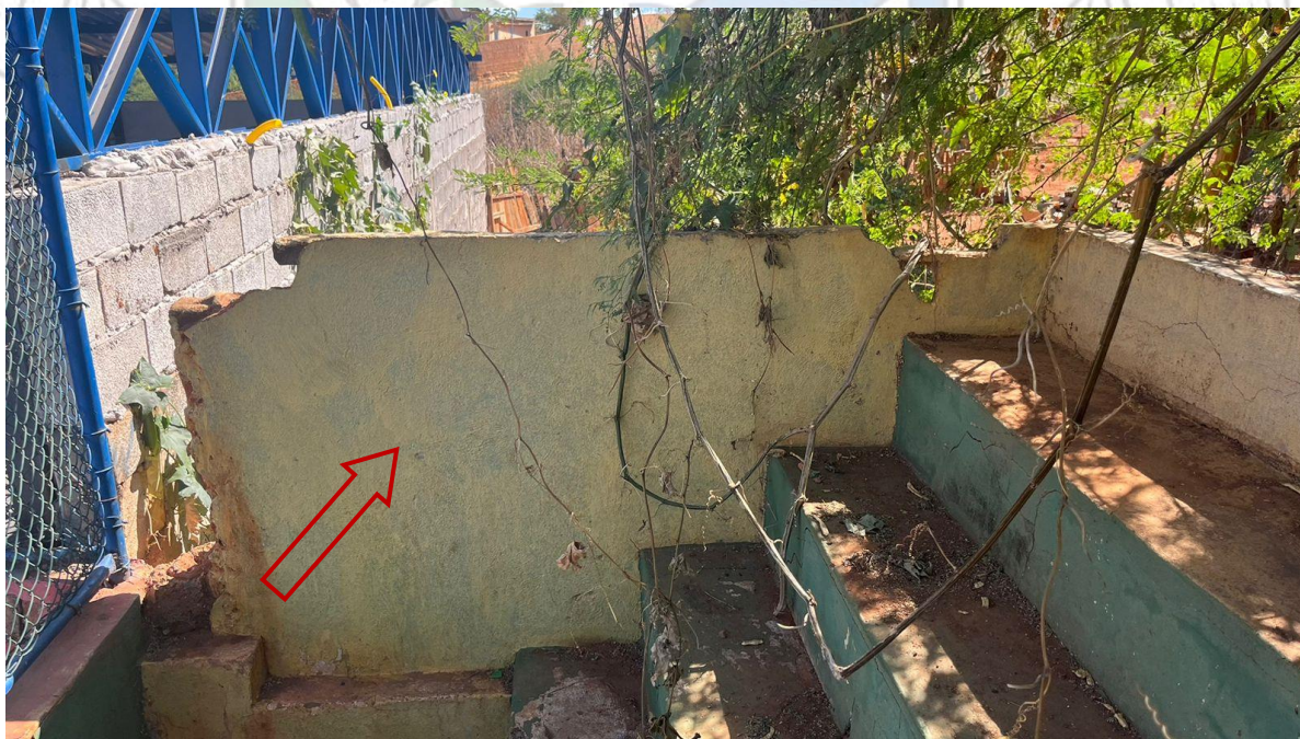
Alvenaria que será ampliada
