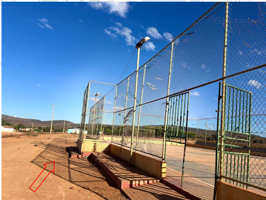
Área onde será pavimentado e haverá a construção de uma arquibancada
