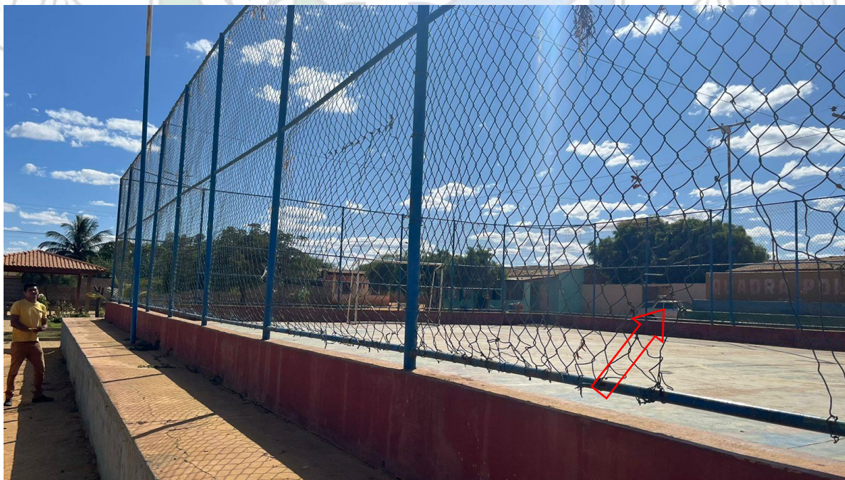
Recuperar tela de alambrado
