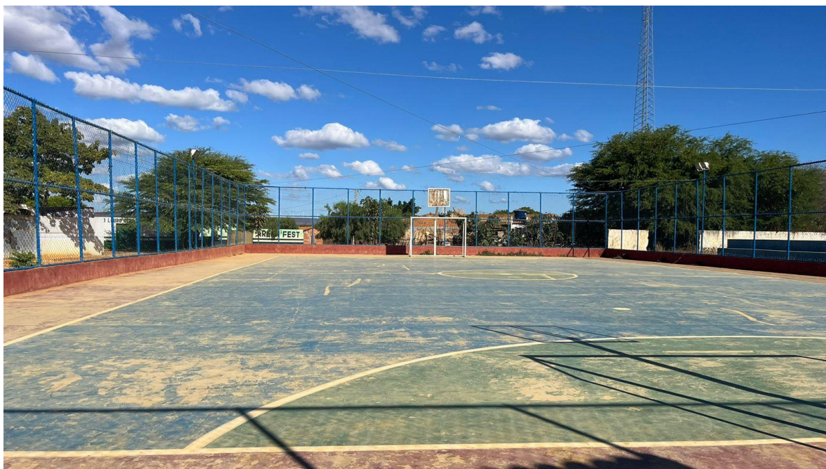
Pavimentação de quadra a ser restaurada
