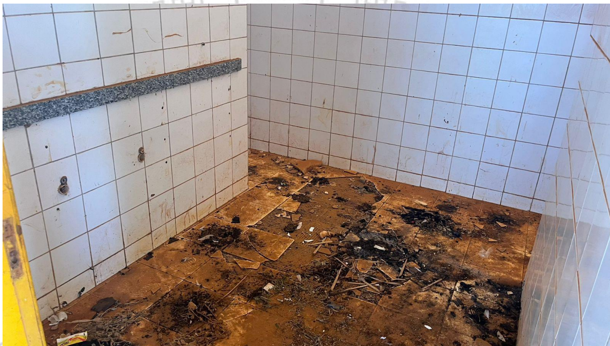
Remoção de piso dos vestiários
