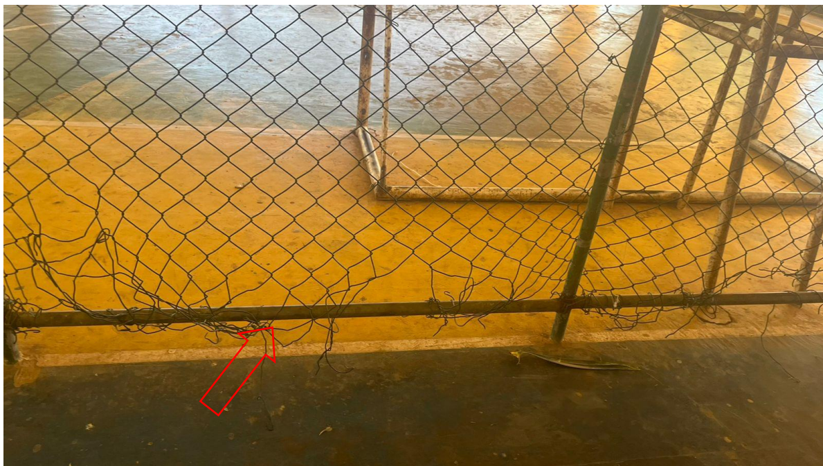
Recuperação de tela do alambrado
