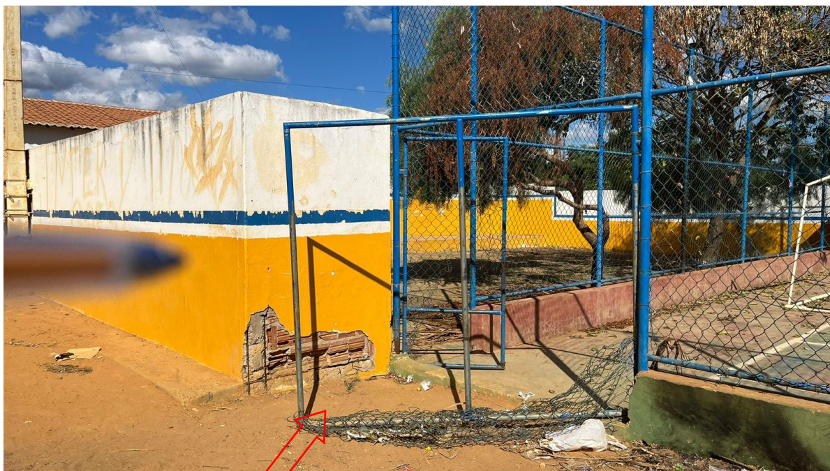
Área onde será executado o passeio
