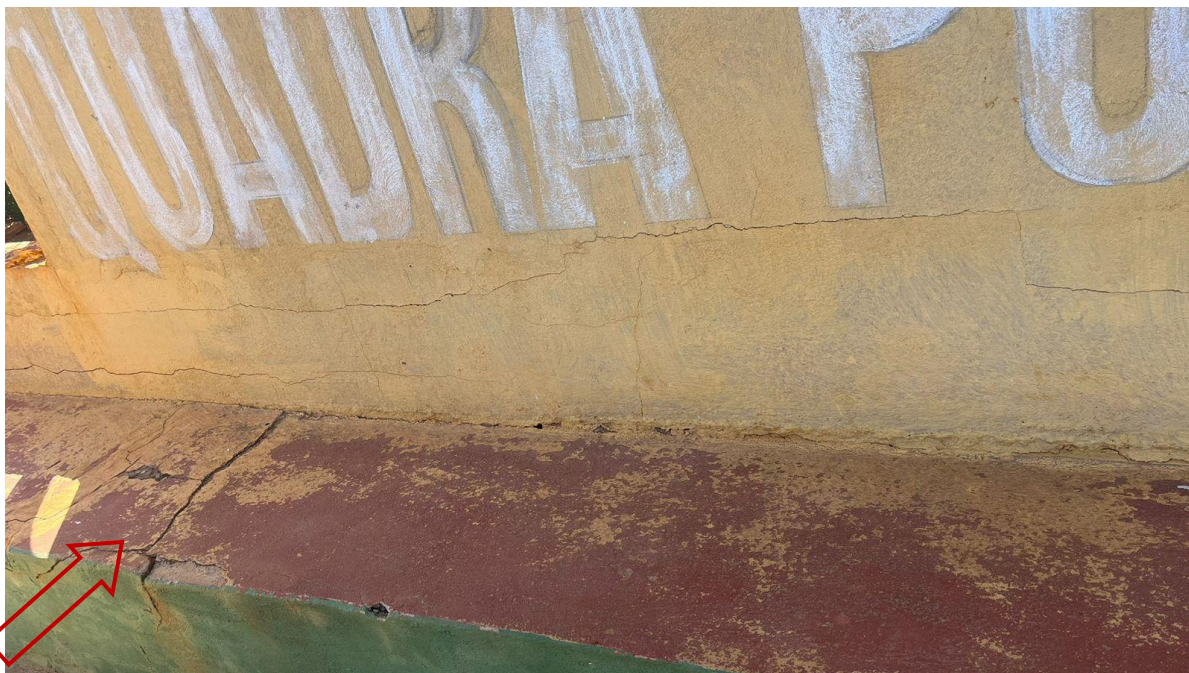
Recuperação de arquibancada
