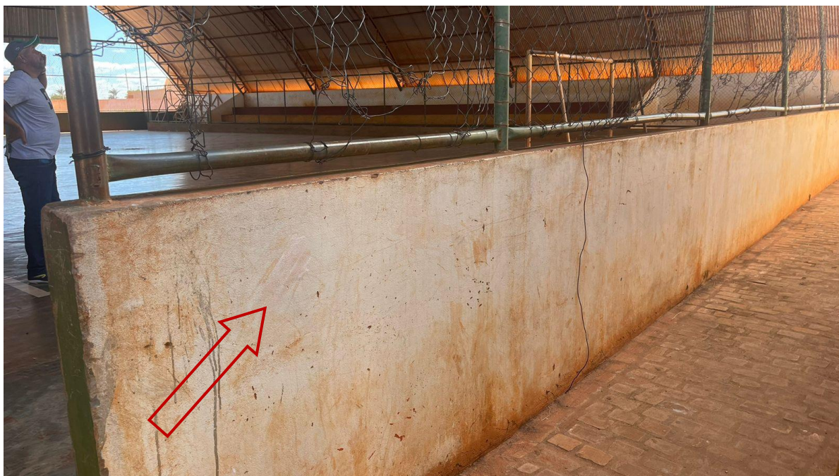
Revestimento de pintura a ser feito
