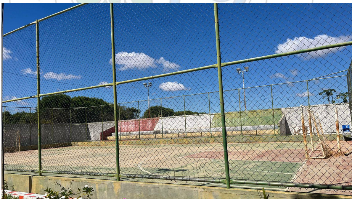
Reparo em mureta, alambrado e pavimentação da quadra
