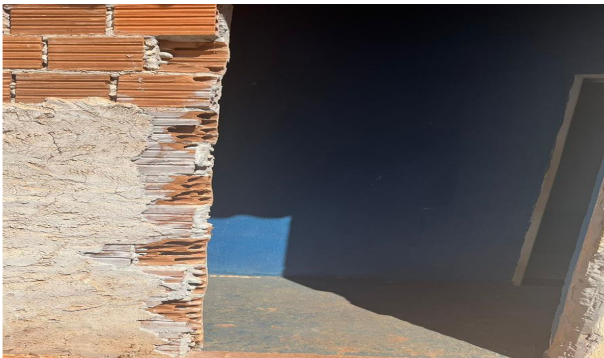
Área do banheiro que será rebocada e revestida com pintura.
