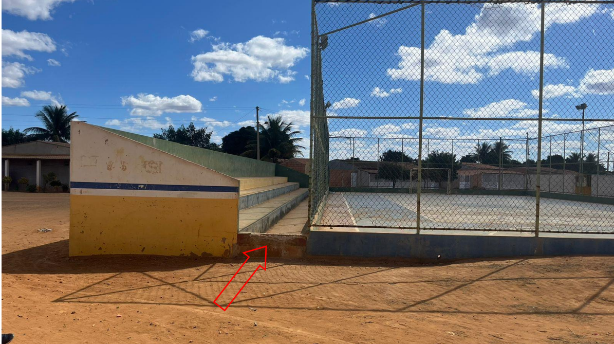
Demolir mureta e realizar a construção de uma rampa
