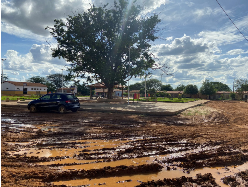
FOTO 03 – POVOADO DE QUEIMADA DE TIANO
