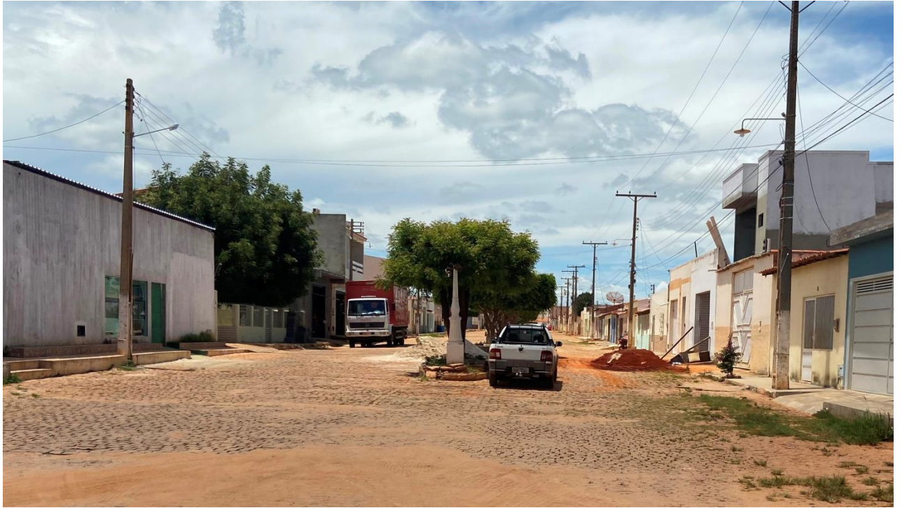
FOTO 05 – AVENIDA ACM, SEDE
