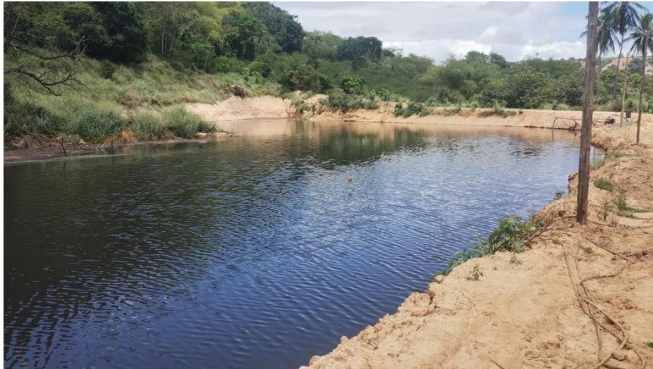
Foto 03: Bacias com esgoto bruto armazenado.
