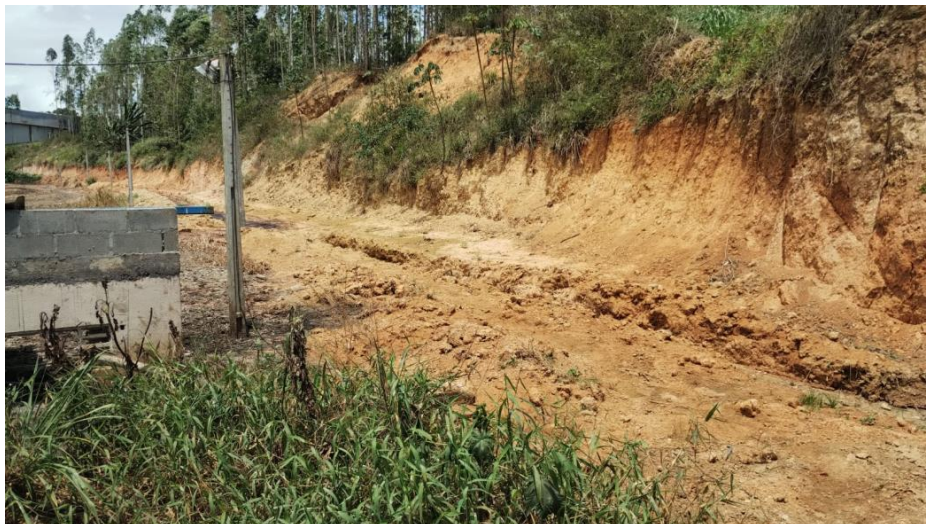
Foto 04: Vala aberta para drenagem de água pluvial.
