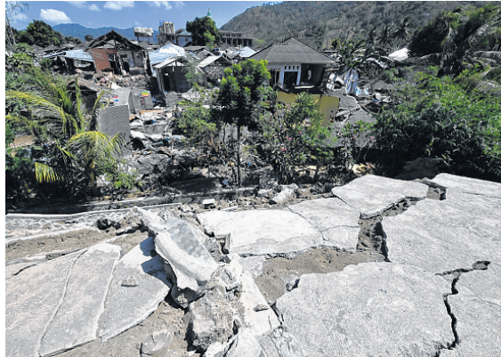
Casas rachadas e muito danificadas são vistas em Pemenang, norte de Lombok
