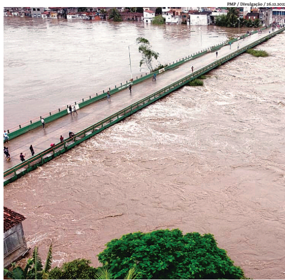
Em Ipiatã, o rio subiu até alcançar o nível da ponte, causando diversos prejuízos
