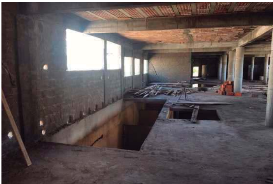
Pav. Superior - abertura escada e plataforma elevada.
