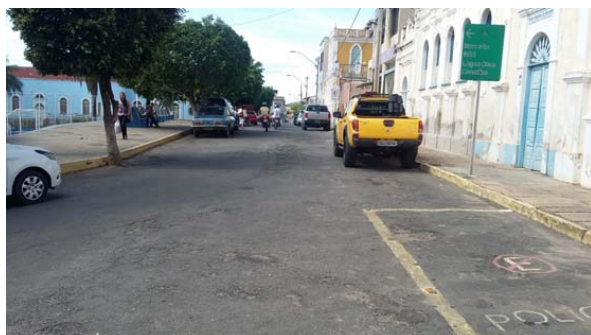
Foto 9 - Trecho a ser feito capeamento asfáltico na Rua Abílio Cesar Borges
