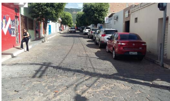
Foto 4 - Trecho a ser feito capeamento asfáltico da Rua Dr. Vital Soares
