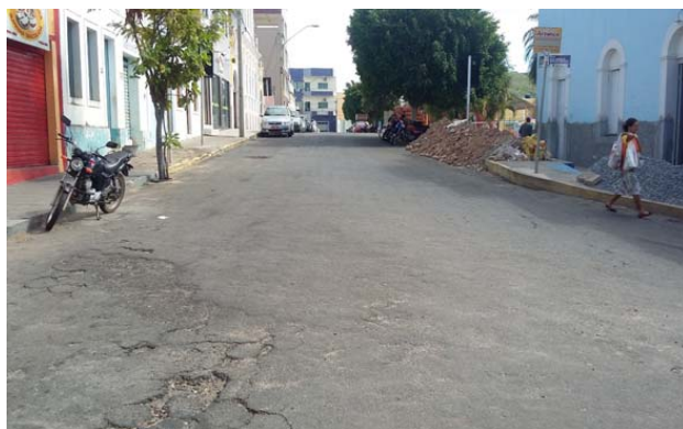
Foto 10 - Trecho a ser feito capeamento asfáltico na Rua Abílio Cesar Borges
