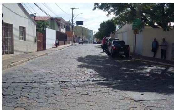
Foto 3 - Trecho a ser feito capeamento asfáltico da Av. Flores da Cunha
