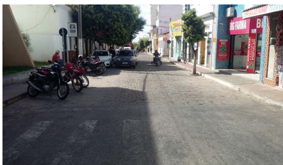
Foto 5 - Trecho a ser feito capeamento asfáltico da Rua Dr. Vital Soares
