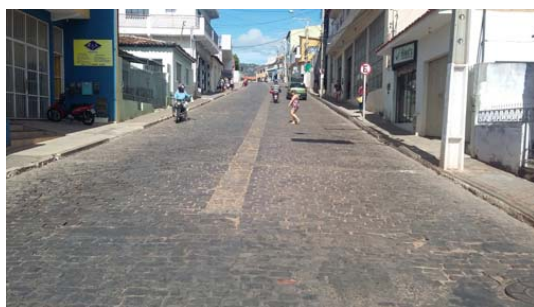
Foto 1 - Trecho a ser feito capeamento asfáltico da Av. Flores da Cunha
