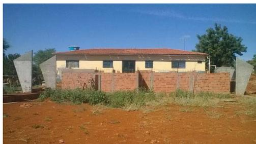
Foto 1: Levantamento parcial de paredes dos Vestiários.
