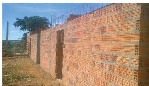
Foto 2 - Montagem das Ferragens com inconformidades.
