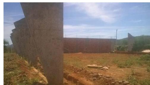
Foto 4: Execução dos Pilares Estruturais da Cobertura
