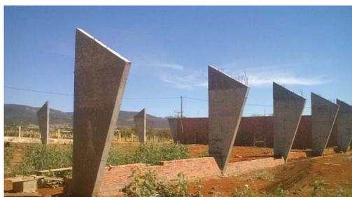
Foto 5: Execução dos Pilares Estruturais da Cobertura.
