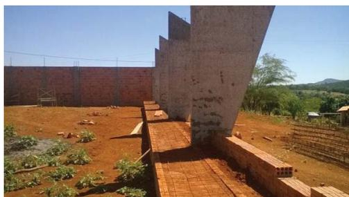
Foto 3: Execução dos Pilares Estruturais da Cobertura.
