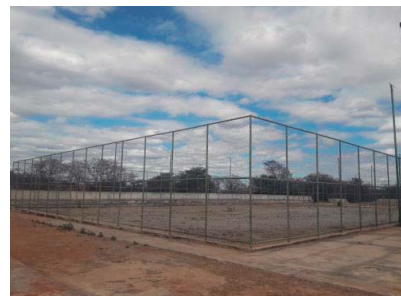
Foto 6 Pintura nas Estruturas Metálicas - Quadras
