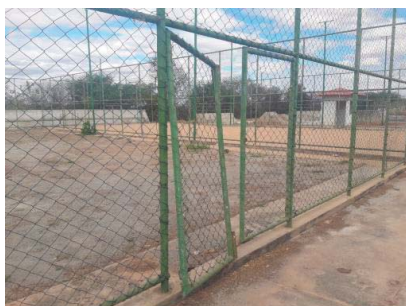
Foto 7 Reforma dos Portões Tubular – Quadras
