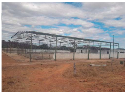
Foto 5 Pintura nas Estruturas Metálicas – Quadras
