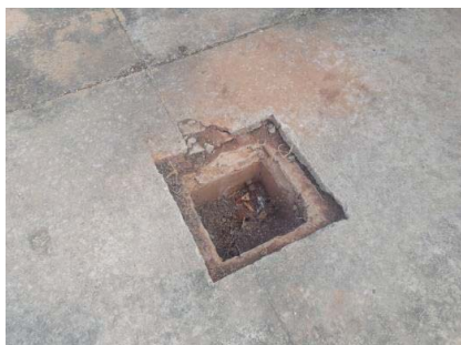
Foto 13 - Confecção de Tampas de Concreto.
