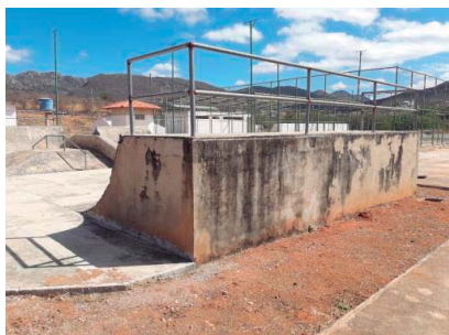
Foto 3 Execução de Piso despolado nas Rampas
