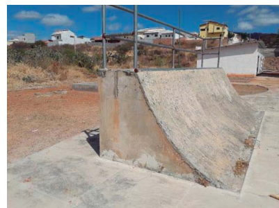
Foto 4 Execução de Piso despolado nas Rampas
