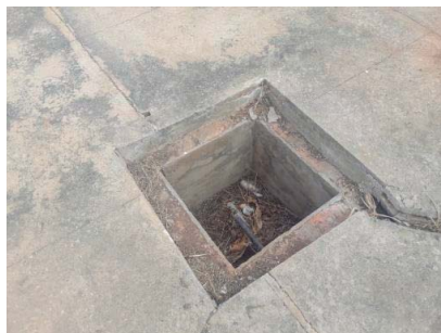
Foto 14 - Confecção de Tampas de Concreto.
