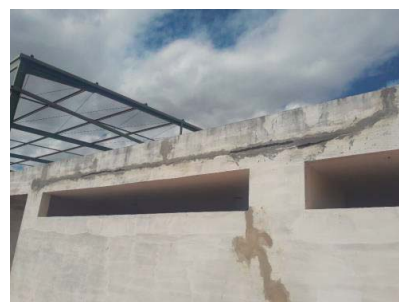
Foto 12 - Reforma estrutural paredes do Vestiário.
