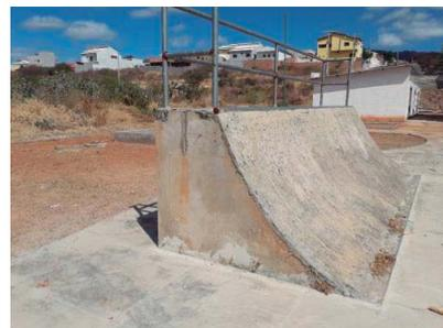
Foto 4 Execução de Piso despolado nas Rampas
