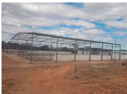
Foto 5 Pintura nas Estruturas Metálicas – Quadras
