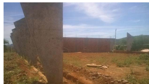
Foto 4: Execução dos Pilares Estruturais da Cobertura
