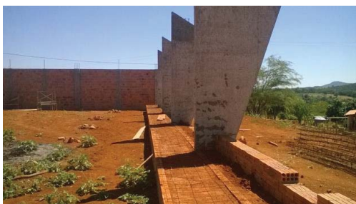
Foto 3: Execução dos Pilares Estruturais da Cobertura.
