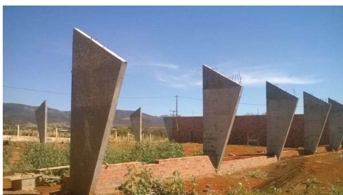
Foto 5: Execução dos Pilares Estruturais da Cobertura.
