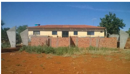
Foto 1: Levantamento parcial de paredes dos Vestiários.
