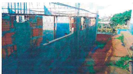
Foto 9 – Montagem de Vigas Superiores.
