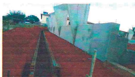
Foto 10 – Execução de Canaletas p Águas Pluviais.
