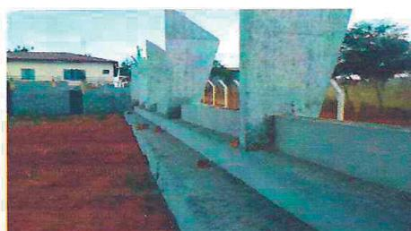
Foto 5 – Execução das Arquibancadas em alvenaria.
