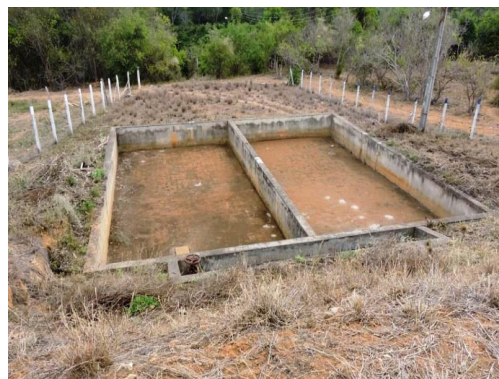
Figuras 39 e 40 – Tanque adensador e leito de secagem – Sistema de reaproveitamento de água
