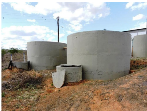
Figuras 39 e 40 – Tanque adensador e leito de secagem – Sistema de reaproveitamento de água
