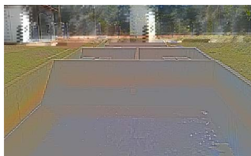
Figuras60 e 61 –Decantador e leito de secagem da ETA Perucas
