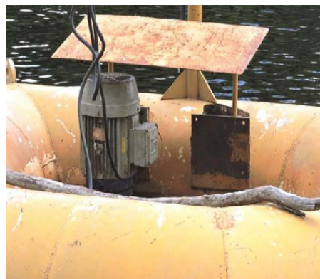
Figuras 31 e 32 – Captação com flutuante
