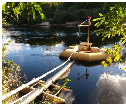
Figuras 31 e 32 – Captação com flutuante
