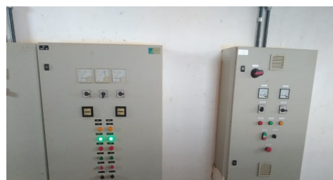
Figuras64 e 65 –EEAT 1 e 2 e Quadro de comando ETA Perucas
