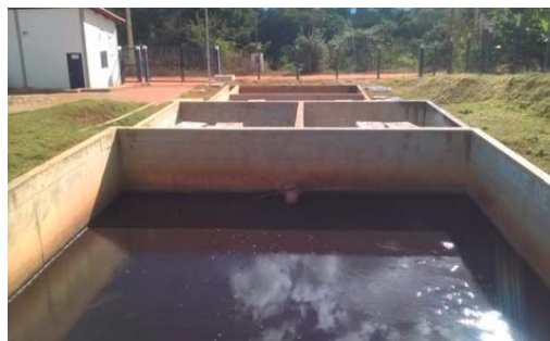
Figuras60 e 61 –Decantador e leito de secagem da ETA Perucas
