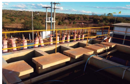
Figuras 33 e 34 – Estação de Tratamento de Água - Filtros e decantadores
