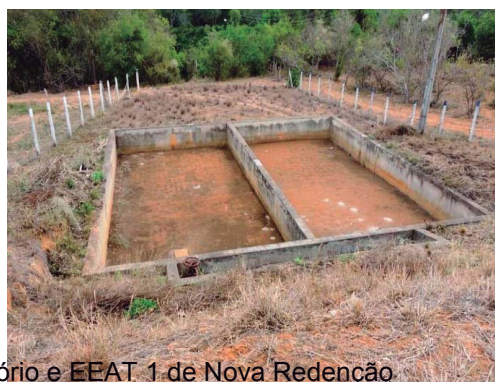
Figuras 39 e 40 – Tanque adensador e leito de secagem – Sistema de reaproveitamento de água
