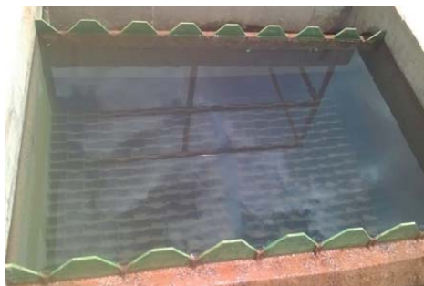
Figuras60 e 61 –Decantador e leito de secagem da ETA Perucas
