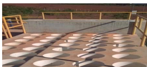
Figuras 58 e 59 – Floculadores e decantadores da ETA Perucas
