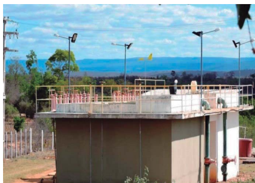
Figuras 33 e 34 – Estação de Tratamento de Água - Filtros e decantadores
