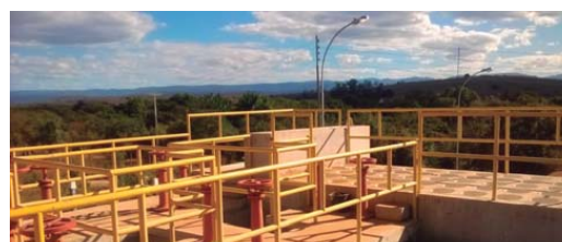
Figuras 58 e 59 – Floculadores e decantadores da ETA Perucas
