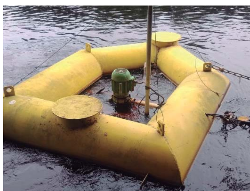
Figuras 58 e 59 – Floculadores e decantadores da ETA Perucas
