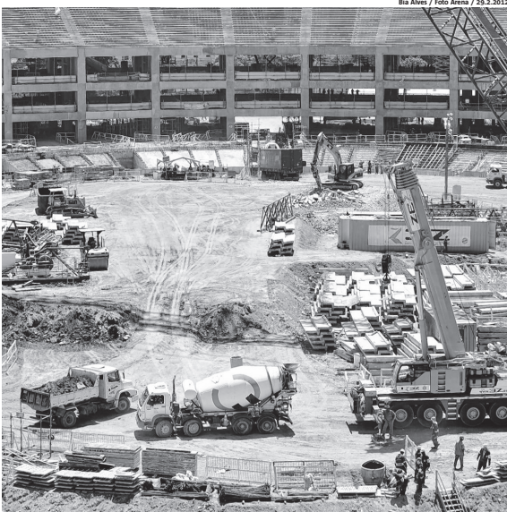
Trabalhadores dão pique na obra da arena para o governo comemorar entrega na data prometida
