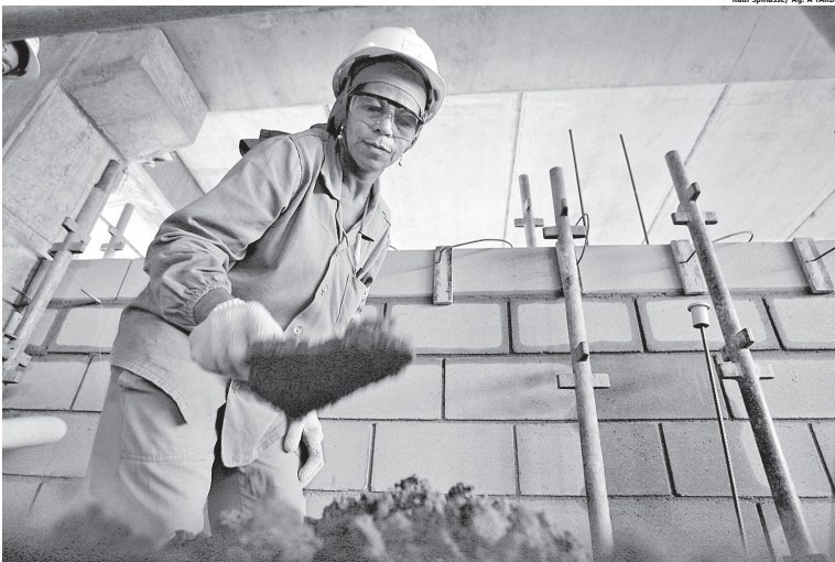
A ajudante de pedreiro Joselita dos Santos precisou driblar a resistência do pai, que a proibiu de trabalhar em um canteiro de obras
