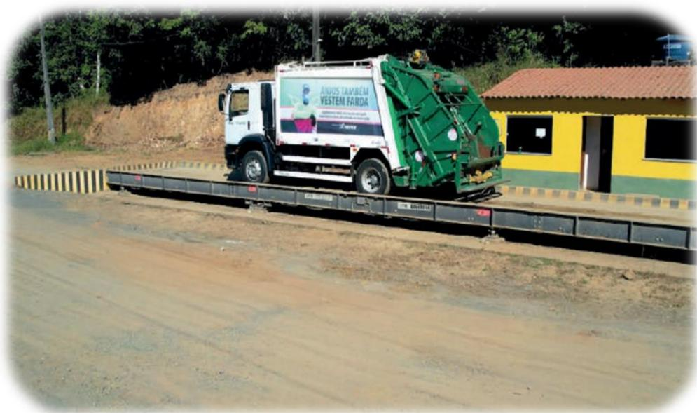
Na recepção da CVR COSTA DO CACAU, os veículos são pesados através do sistema de balança rodoviária e os registros de pesagem são inseridos automaticamente no sistema de gestão interna.
