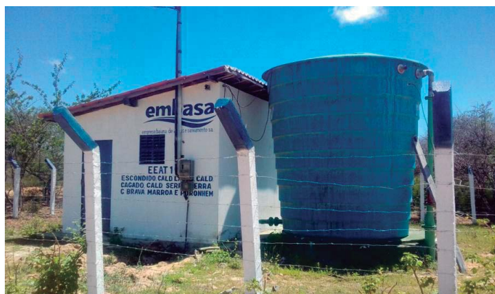
Figura 2.6 – Reservatório e EEAT 1.
