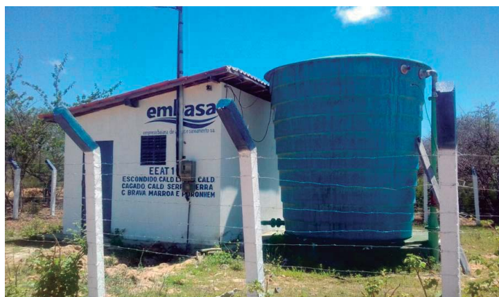
Figura 2.6 – Reservatório e EEAT 1.
