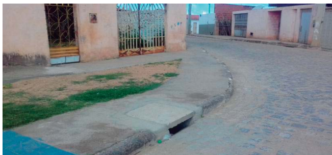
Figura 2.16 – Detalhes do sistema de drenagem urbana na sede municipal.
