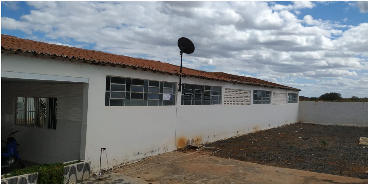
IMAGEM 01: Vista frontal parte externa. Arquivo do Autor 2021
