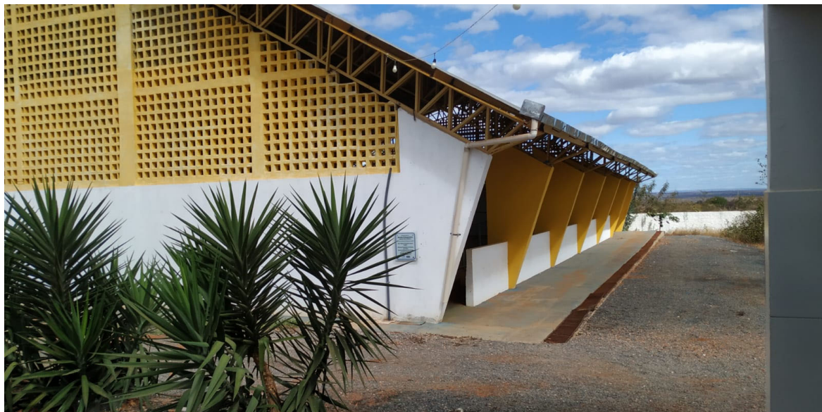
IMAGEM 06: Área externa (Quadra Poliesportiva). Arquivo do Autor 2021.
