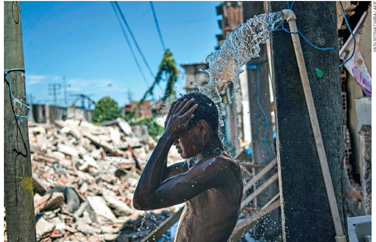
DESAPROPRIAÇÃO Leandro Souza toma banho em frente a área demolida da favela do Metrô, próximo do estádio do Maracanã, no Rio de Janeiro. Moradores foram expropriados das suas casas para construção de um parque como parte das obras para a Copa do Mundo e Olimpíadas de 2016 na capital fluminense. Desde anteontem, eles protestam contra ação do governo do Rio.
