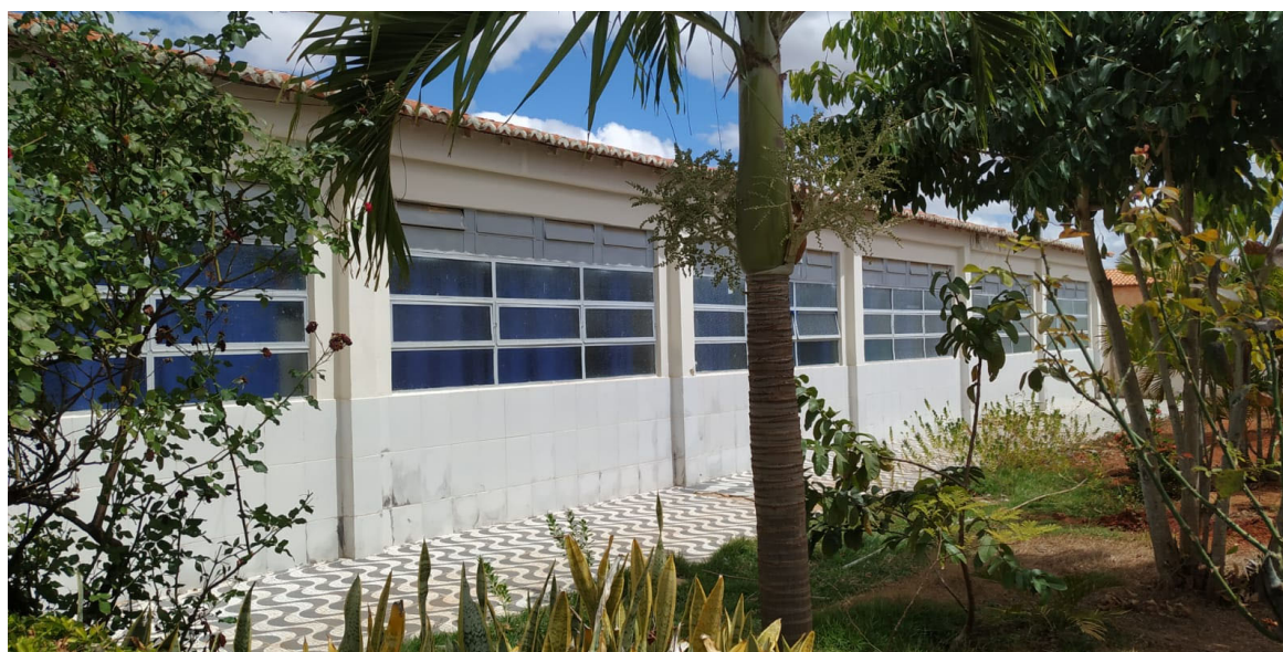
IMAGEM 02: Fachada frontal parte externa. Arquivo do Autor 2021
