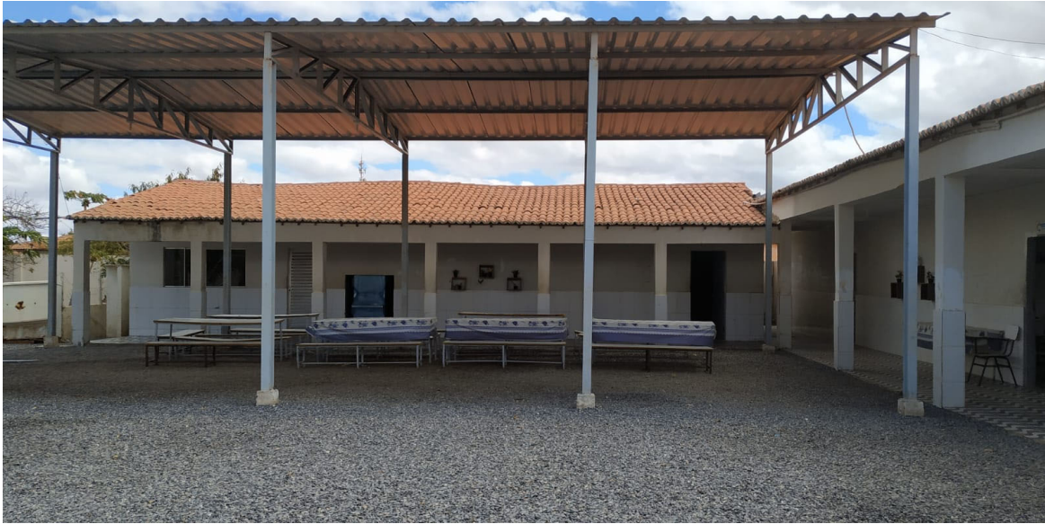
IMAGEM 03: Área externa (Cobertura metálica). Arquivo do Autor 2021
