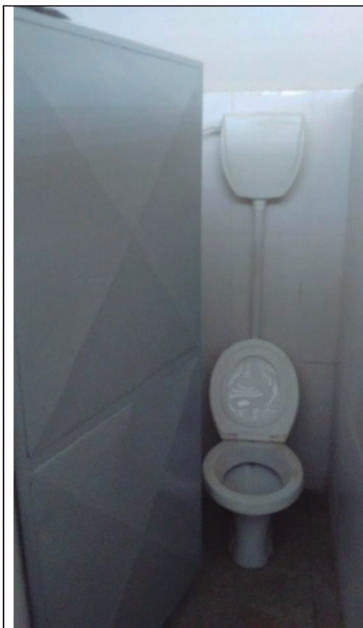
Foto 11 – Portas do banheiro de metal no lugar de portas de madeira – América Dourada\BA, Fevereiro/2017.
