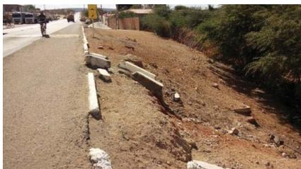
**Figura 5-61 – Deterioração da rampa para escoamento das águas superficiais na rodovia BA-052 - Sede**
