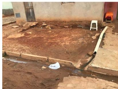
**Figura 5-20 – Lançamento de esgoto na via pública – Sede América Dourada**
