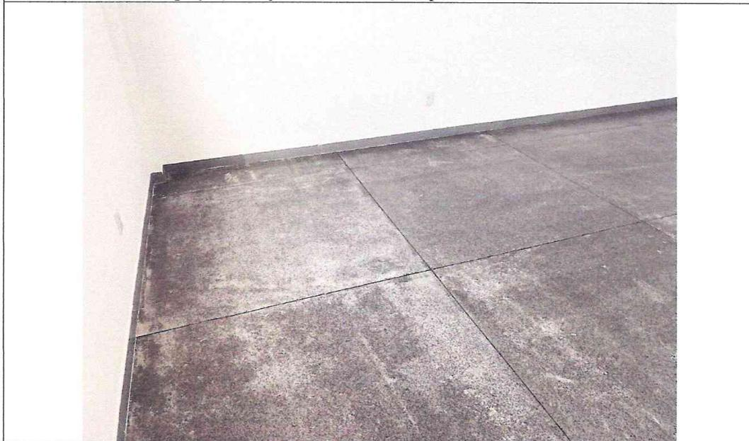
**Foto 07:** *Piso com imperfeições e juntas de dilatação apresentando deslocamento*
