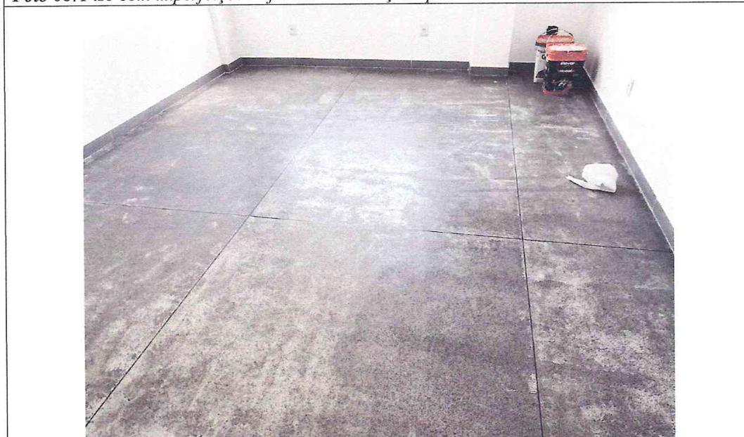
*Foto 09: Piso com imperfeições e juntas de dilatação apresentando deslocamento.*
