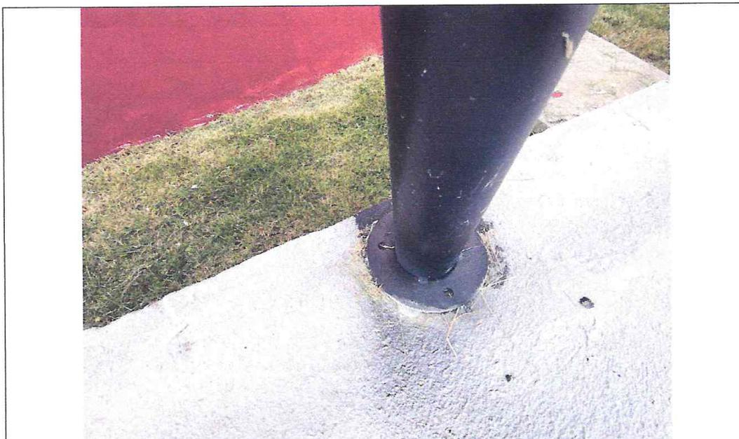
*Foto 04: Guarda corpo com ausência de parafusos de fixação.*
