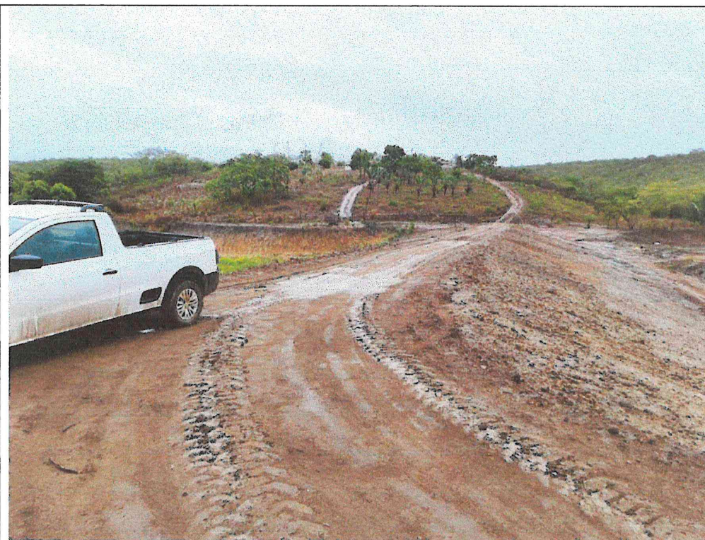
Foto 13: Construção de barreiro na Fazenda Pedra Branca.
