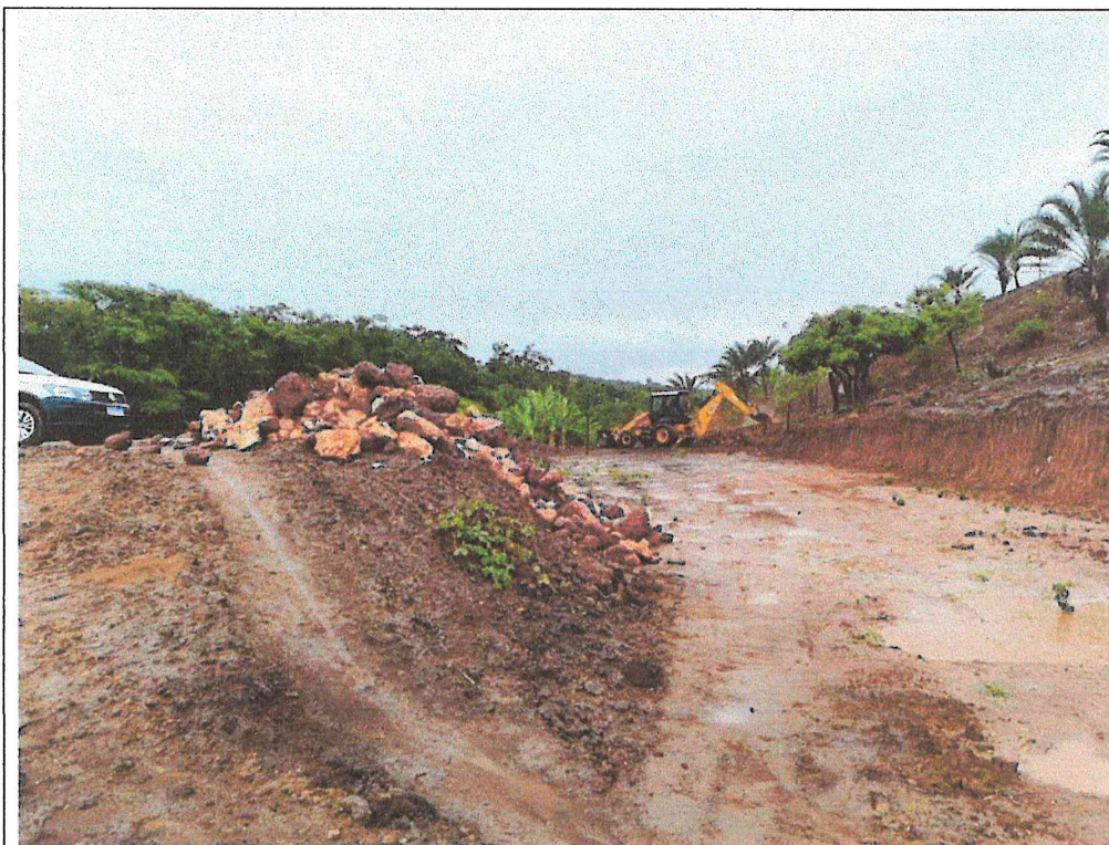
Foto 11: Construção de barreiro na Fazenda Pedra Branca.
