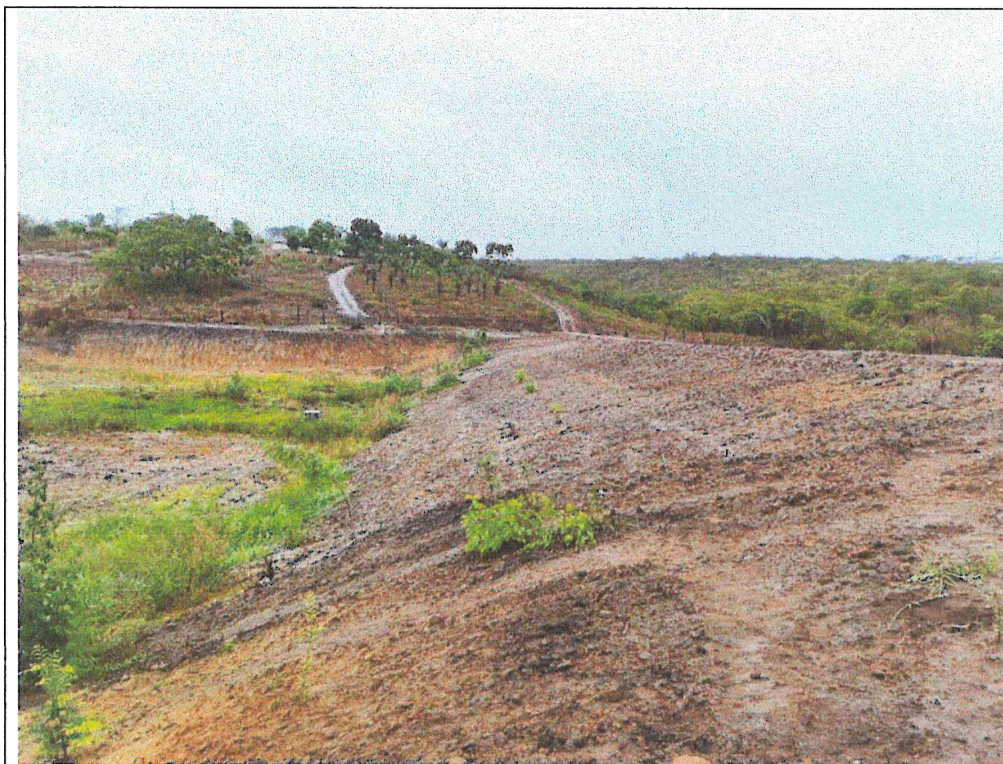
Foto 14: Construção de barreiro na Fazenda Pedra Branca.
