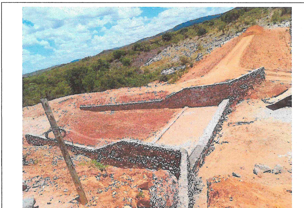
Foto 01: Construção de barreiro na Fazenda Paz.
