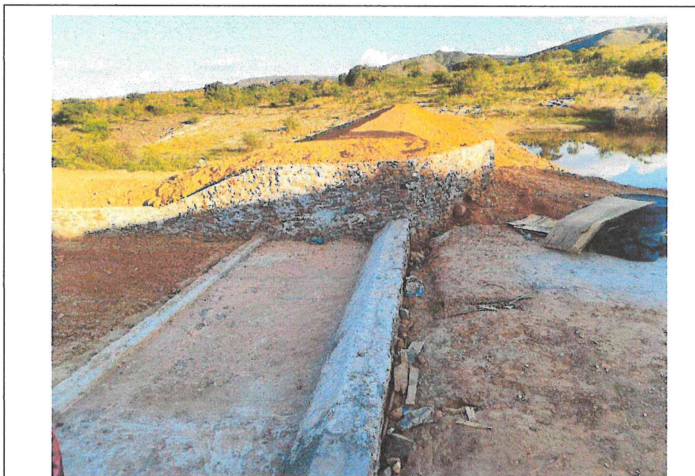
Foto 06: Construção de barreiro na Fazenda Paz.
