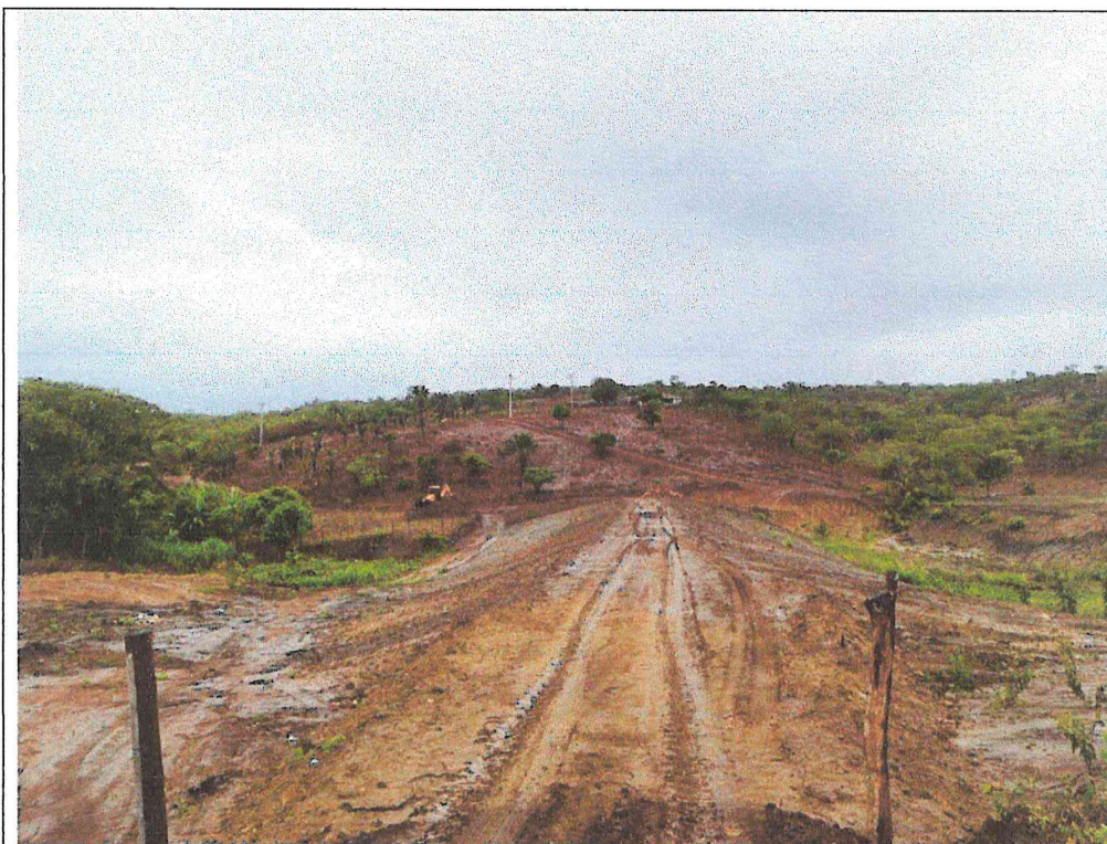
Foto 10: Construção de barreiro na Fazenda Pedra Branca.
