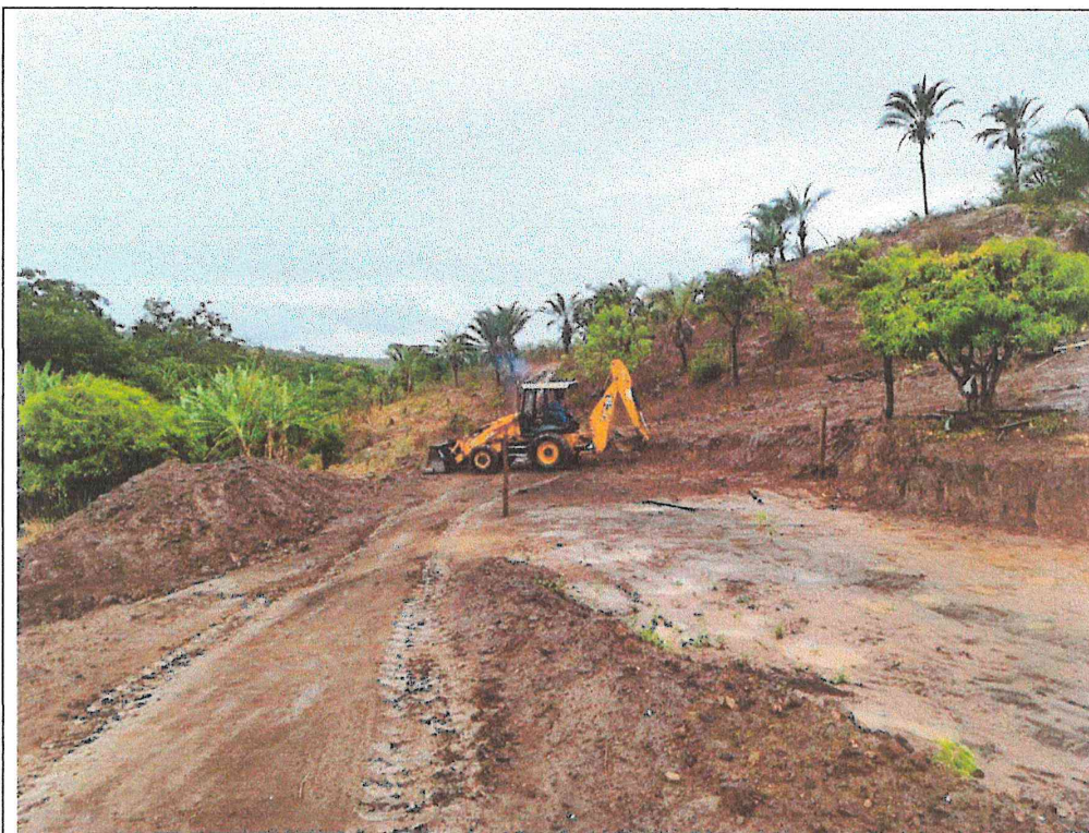
Foto 12: Construção de barreiro na Fazenda Pedra Branca.
