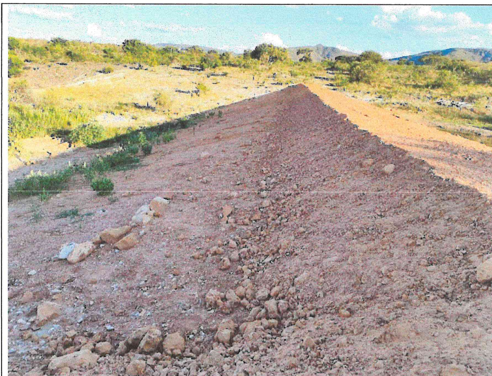
Foto 09: Construção de barreiro na Fazenda Paz.
