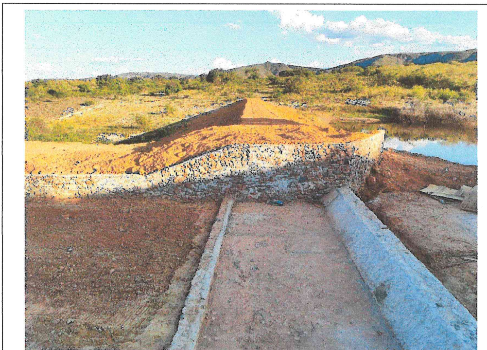
Foto 07: Construção de barreiro na Fazenda Paz.
