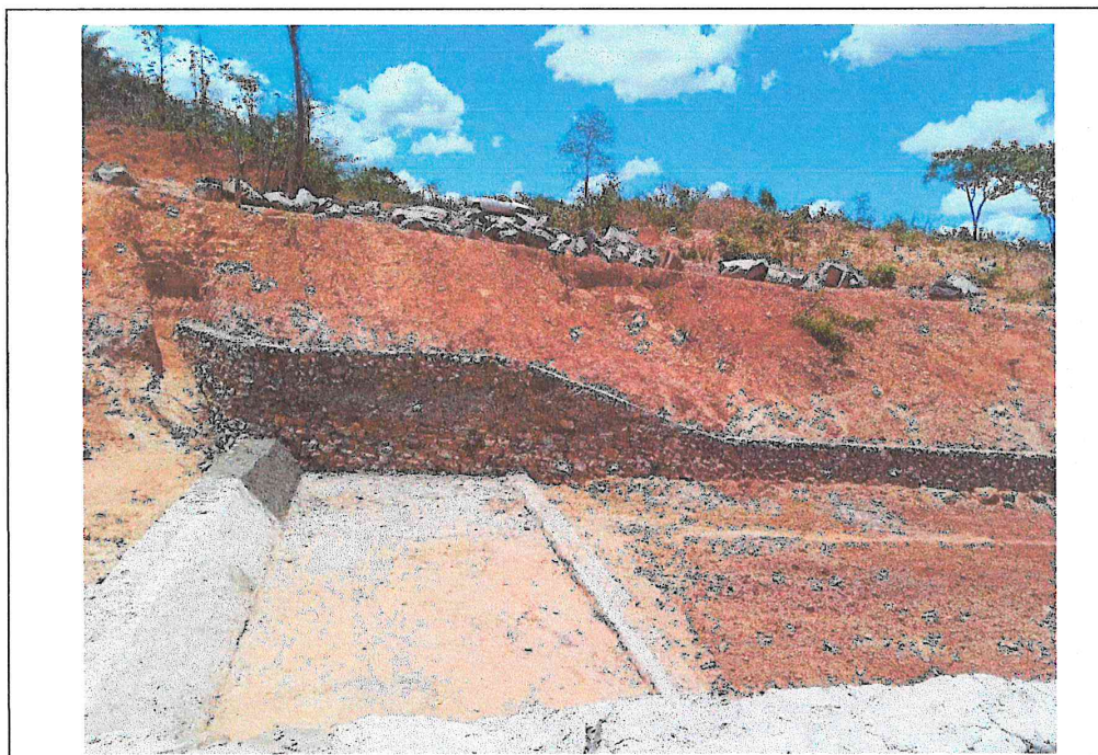
Foto 04: Construção de barreiro na Fazenda Paz.
