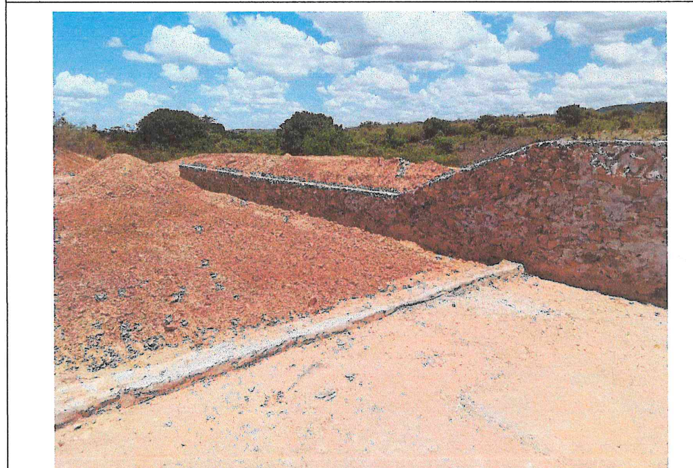
Foto 05: Construção de barreiro na Fazenda Paz.
