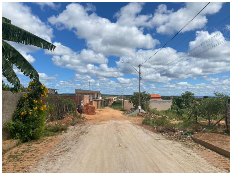
Imagem 08: Estaca 21 Rua João José da Silveira
