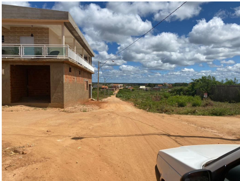
Imagem 06: Estaca 12 Rua João José da Silveira
