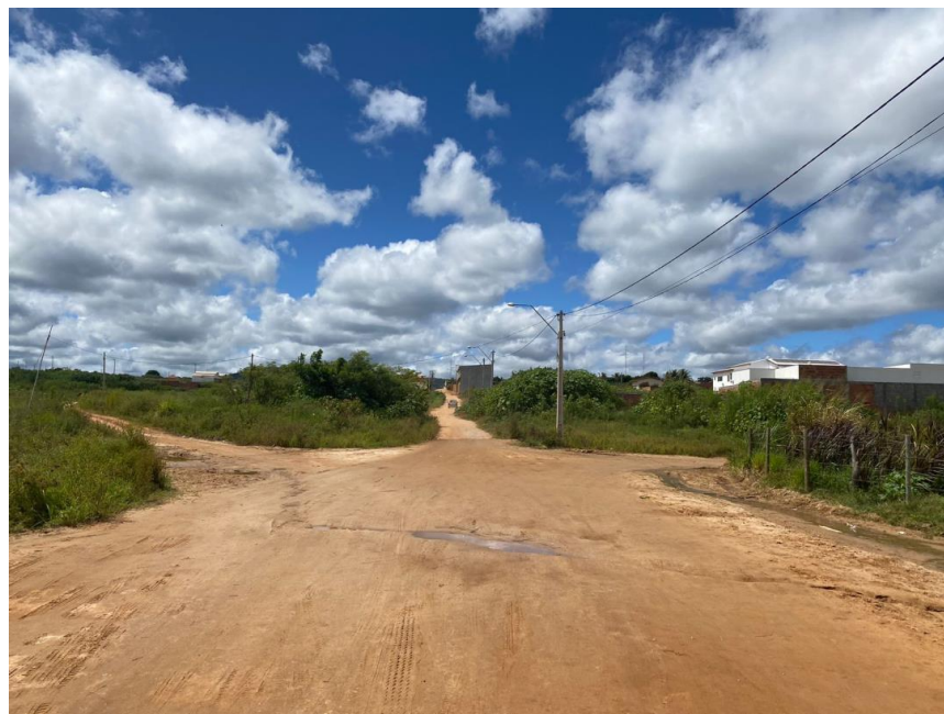
Imagem 04: Estaca 8 Rua João José da Silveira
