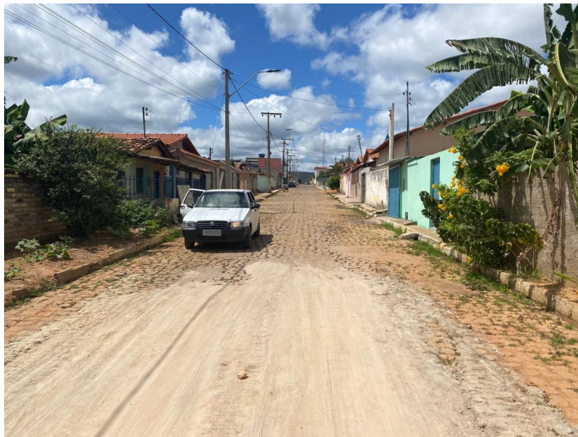
Imagem 7: Estaca 21 Rua João José da Silveira, encontro com o pavimento existente.
