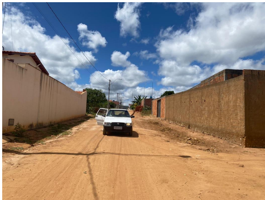
Imagem 05: Estaca 13 Rua João José da Silveira
