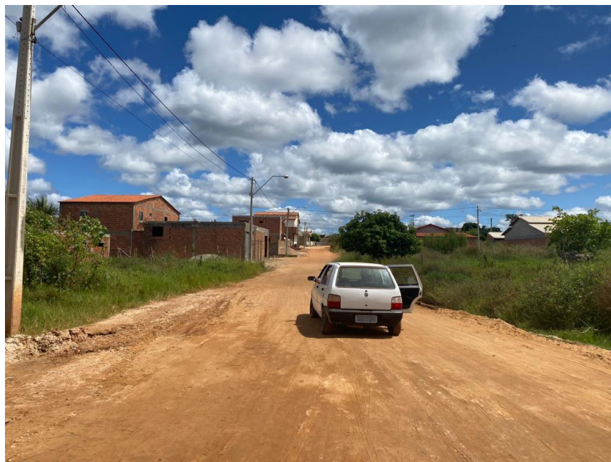
Imagem 03: Estaca 7 Rua João José da Silveira
