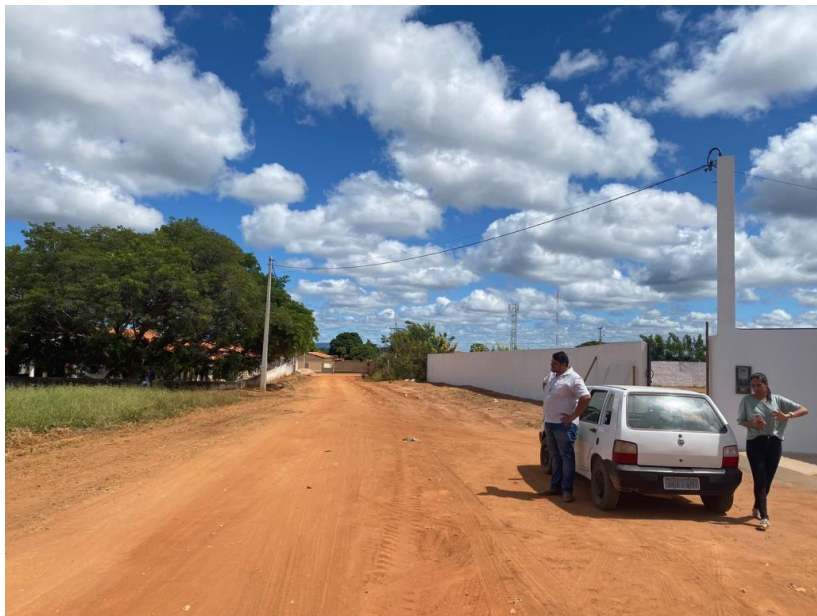
Imagem 09: Estaca 05 Rua Novo Cordeiro
