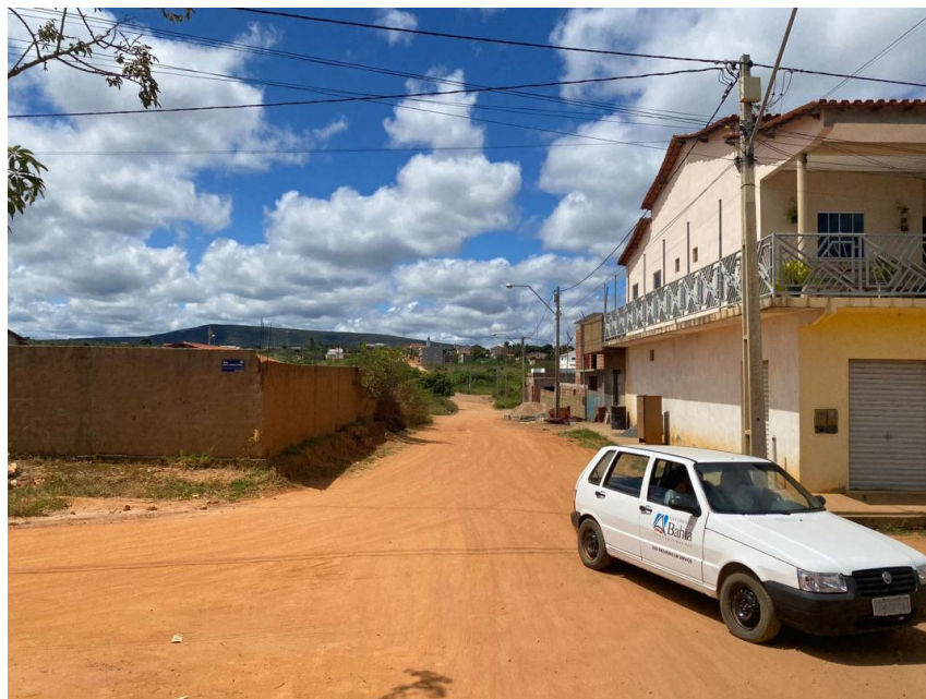
Imagem 02: Estaca 0 Rua João José da Silveira
