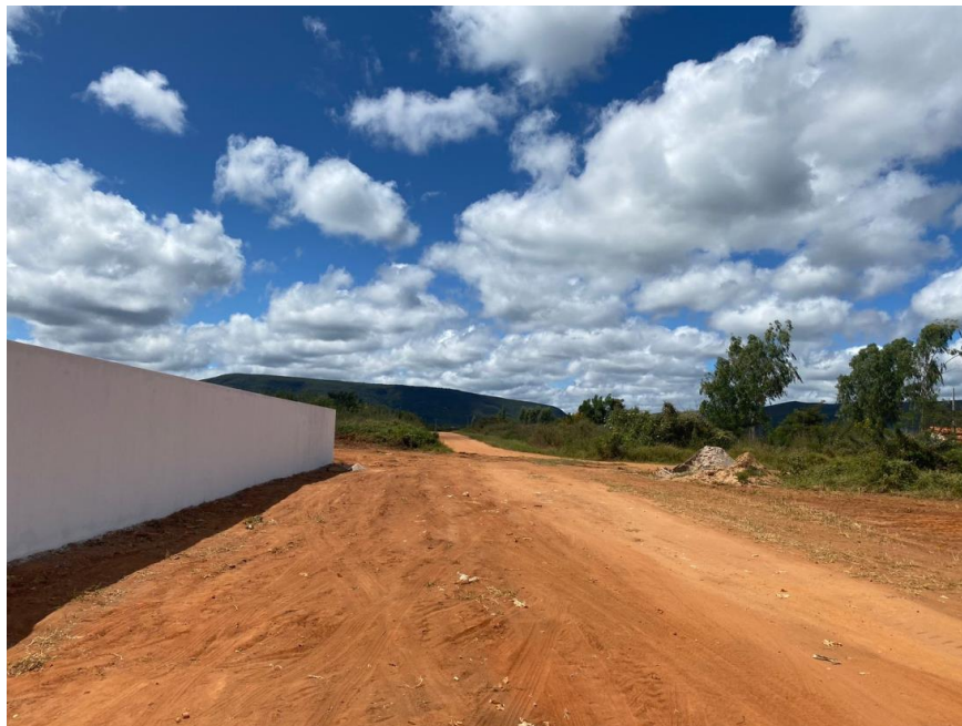
Imagem 10: Estaca 05 Rua Novo Cordeiro
