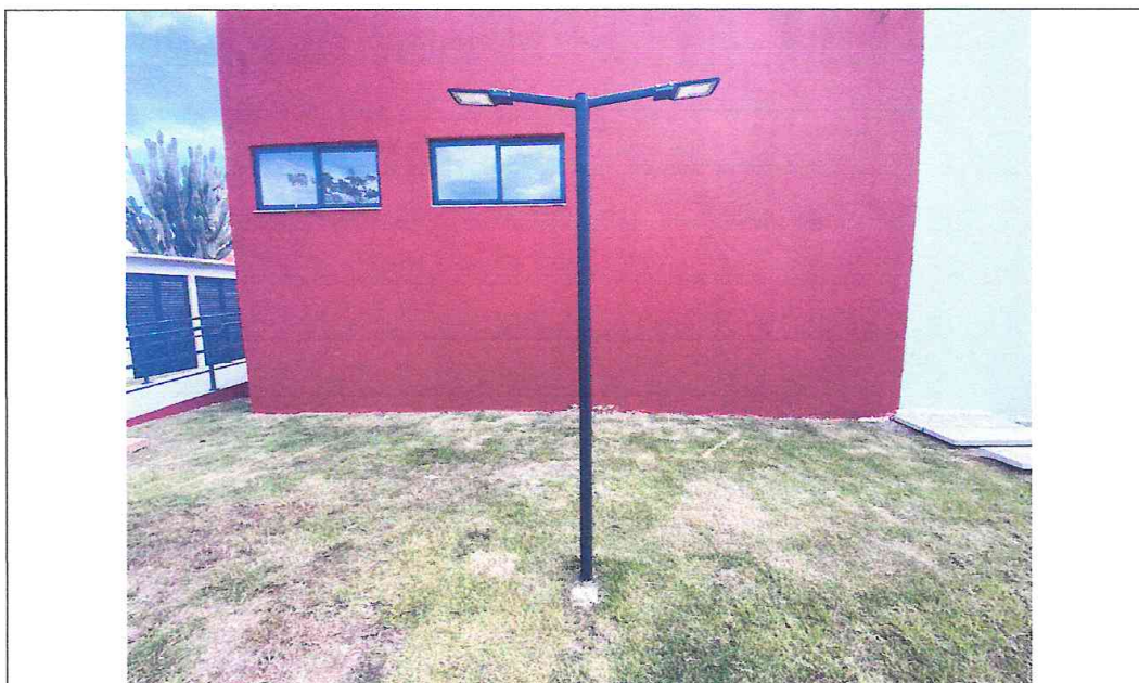
Foto 01: Poste com má fixação.
