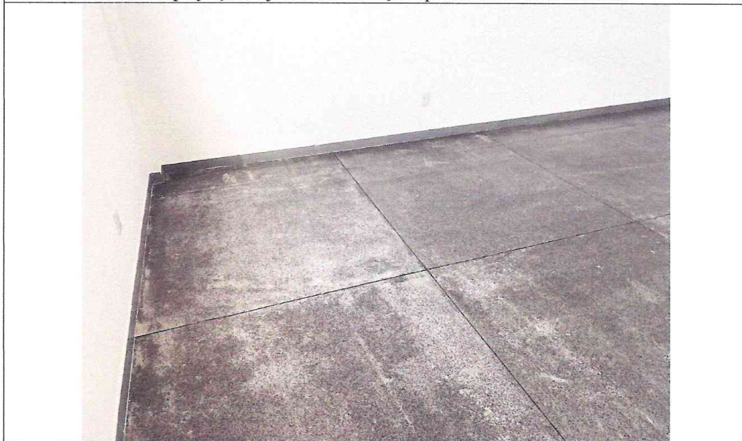
Foto 06: Piso com imperfeições e juntas de dilatação apresentando deslocamento
